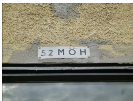
Figur 3 Fasad detaljer som skyddas med skyddsbestämmelser. Från vänster, höjdangivelse för stationsläget, spritputsad fasad med slätputsning runt fönstren, gesimser i fasaden.
