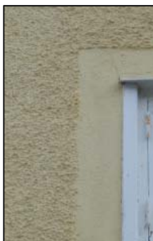
Figur 3 Fasad detaljer som skyddas med skyddsbestämmelser. Från vänster, höjdangivelse för stationsläget, spritputsad fasad med slätputsning runt fönstren, gesimser i fasaden.
