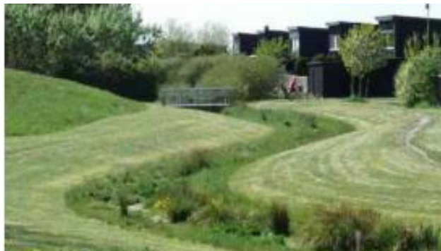
Öppen ytvattenränna – exempel på lokal dagvattenhantering
