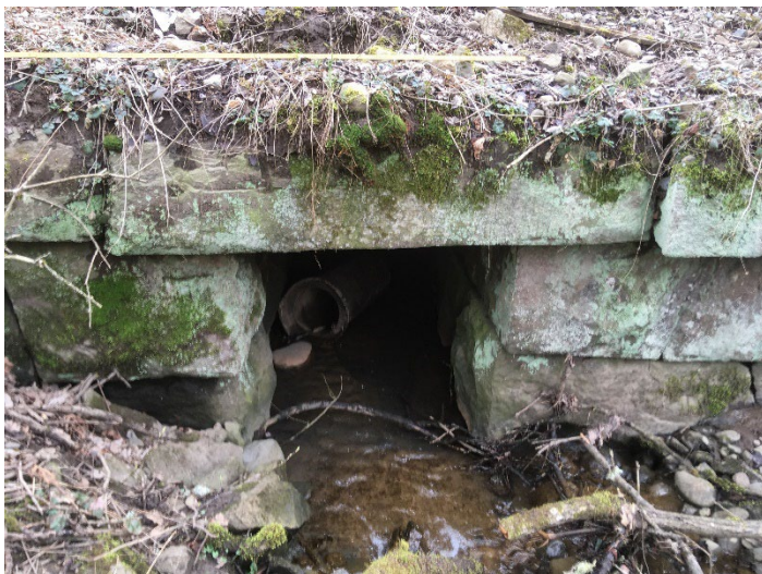
Kulvert under järnvägen
