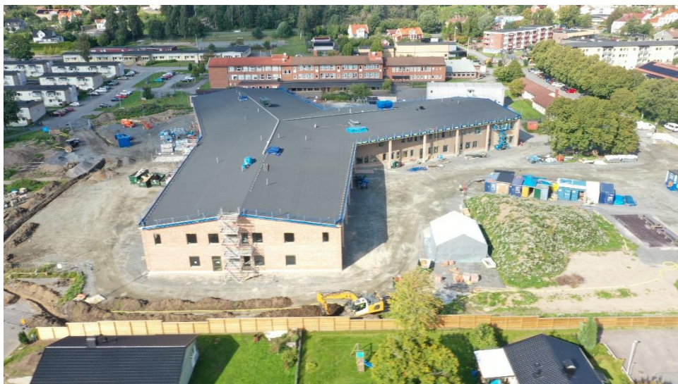
Figur 6 Pågående byggnation sedd från söder
