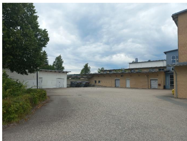
Figur 36. Nuvarande yta som används som vändplats. En av förrådsbyggnaderna syns till vänster och godsmottagning, avfallshantering och entré till skolan på höger sida.
