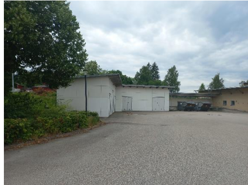
Figur 13. Förrådsbyggnad utanför det inhägnade området.
