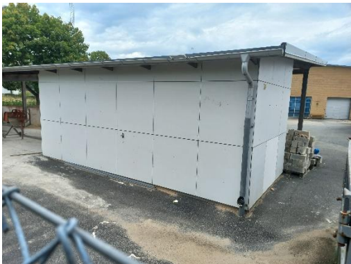
Figur 12. Förrådsbyggnad med gjuten betongplatta mot asfalten.
