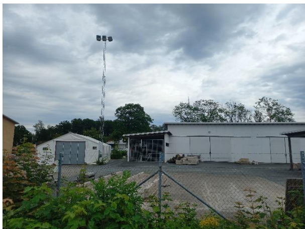
Figur 33. Förrådsbyggnaderna från norr.
