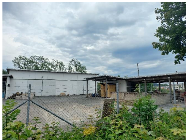
Figur 34. Förrådsbyggnaderna från väster.
