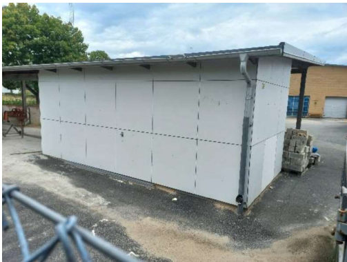
Figur 12. Förrådsbyggnad med gjuten betongplatta mot asfalten.
