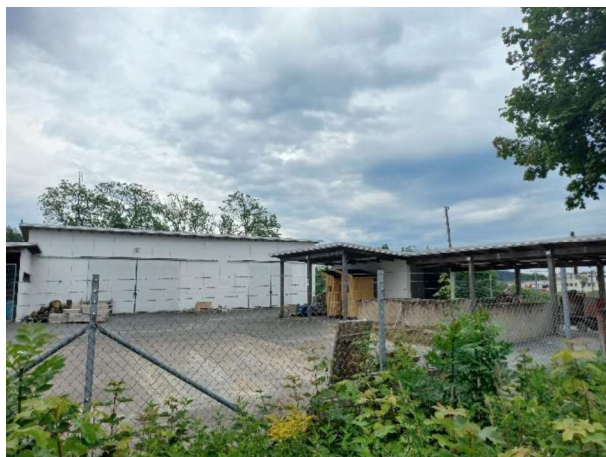
Figur 34. Förrådsbyggnaderna från väster.
