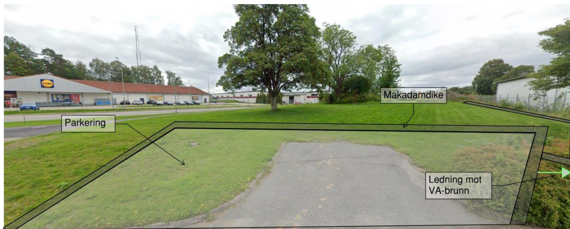
Figur 20-Makadamdiket föreslås att anläggas runt parkeringen som ska anläggas samt längst sidan på byggnaderna intill.
