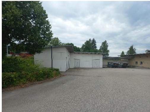
Figur 13. Förrådsbyggnad utanför det inhägnade området.
