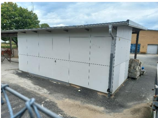
Figur 12. Förrådsbyggnad med gjuten betongplatta mot asfalten.
