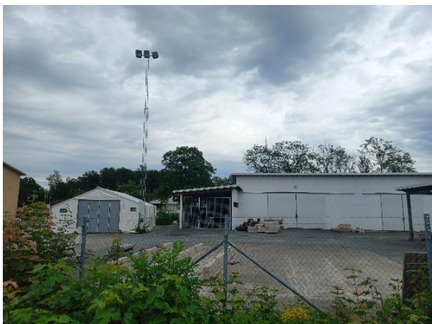
Figur 28. Förrådsbyggnaderna från norr.
