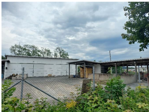
Figur 29. Förrådsbyggnaderna från väster.
