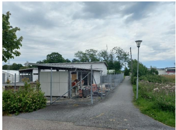
Figur 36. GC-väg mellan Olsa Marjas väg och fram till GC-väg mellan Kinna och Skene.
