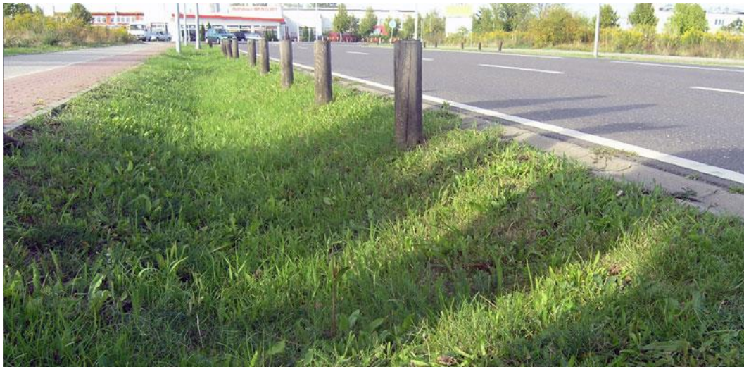
Figur 25- Exempel på makadamdike (Stockholmvattenochavfall, 2024).
