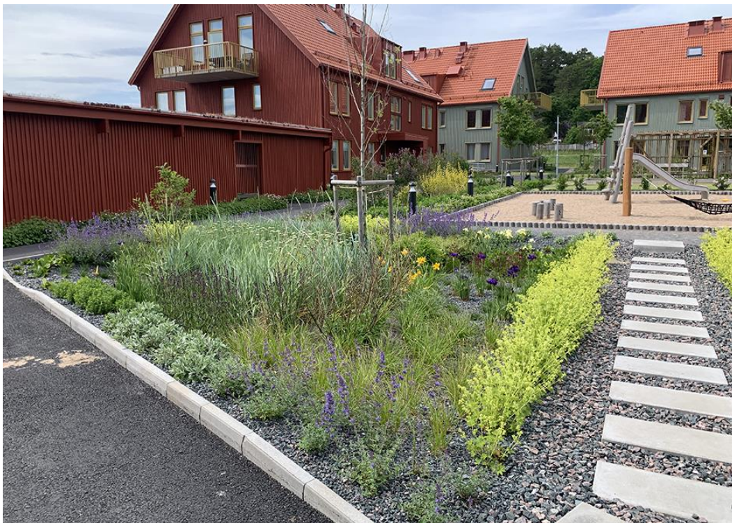
Figur 21- Dagvattenhantering i ett bostadsområde på Nya Särö (Hasselforsgården, 2024).
