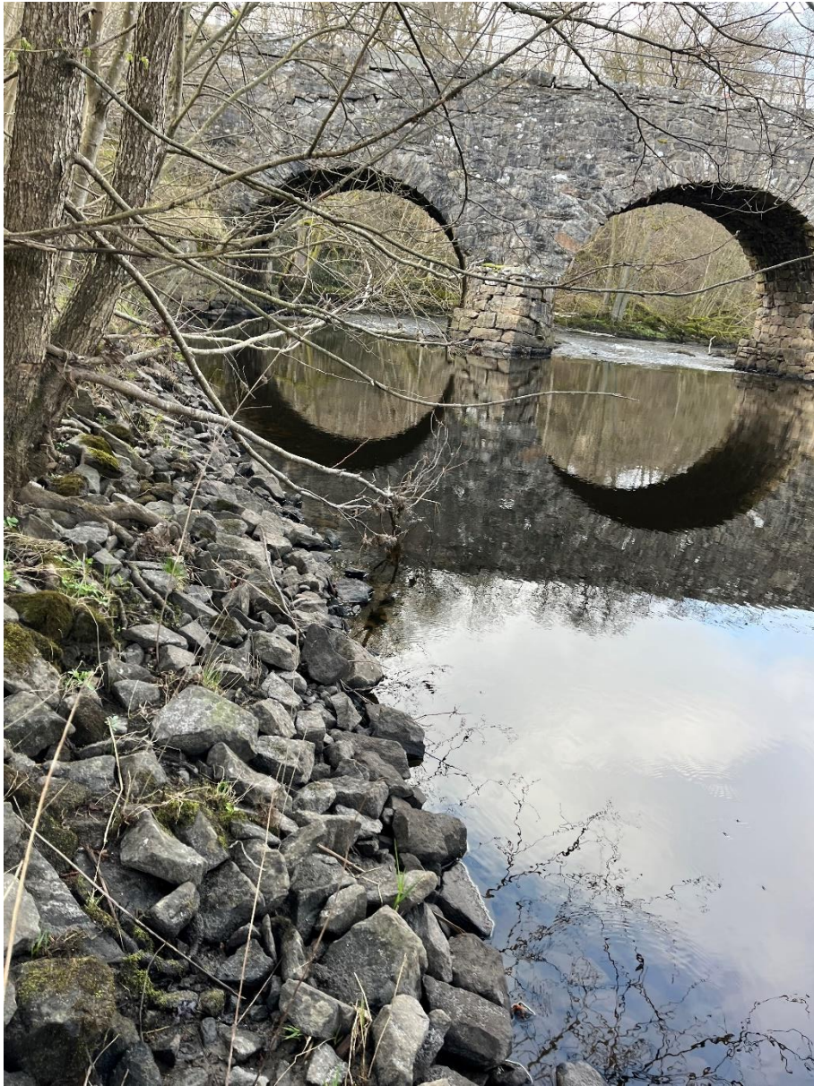
Erosionsskydd finns utlagt längs Viskans strand.
