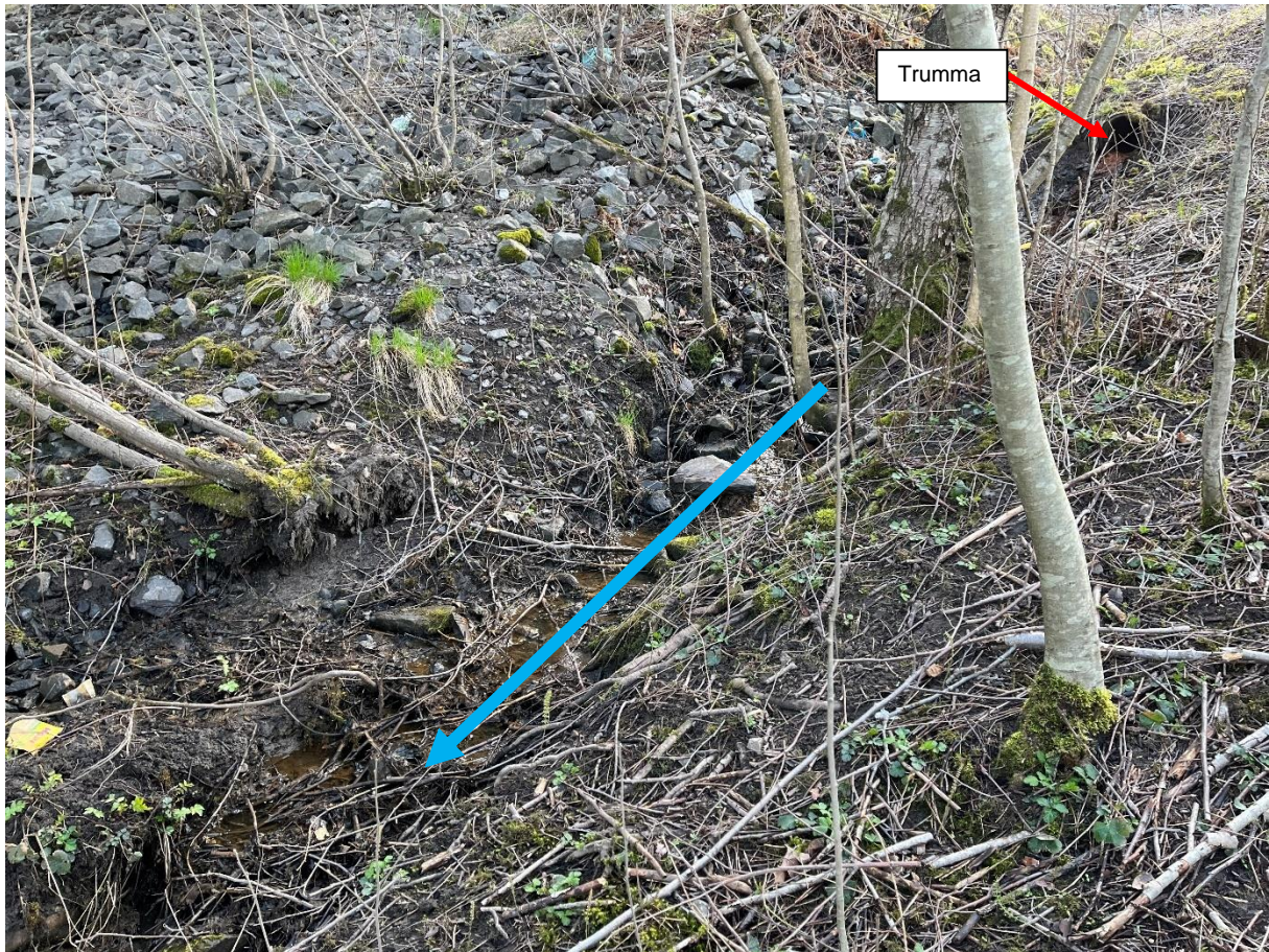
Dagvattnet rinner söderut mot Viskan. Diket har eroderat.
