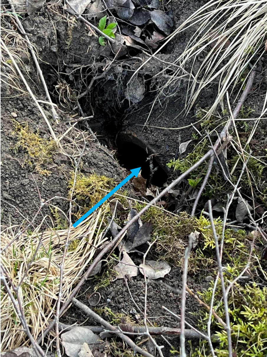
Dagvattnet som infiltrerats i sprängstenen rinner genom en trumma.
