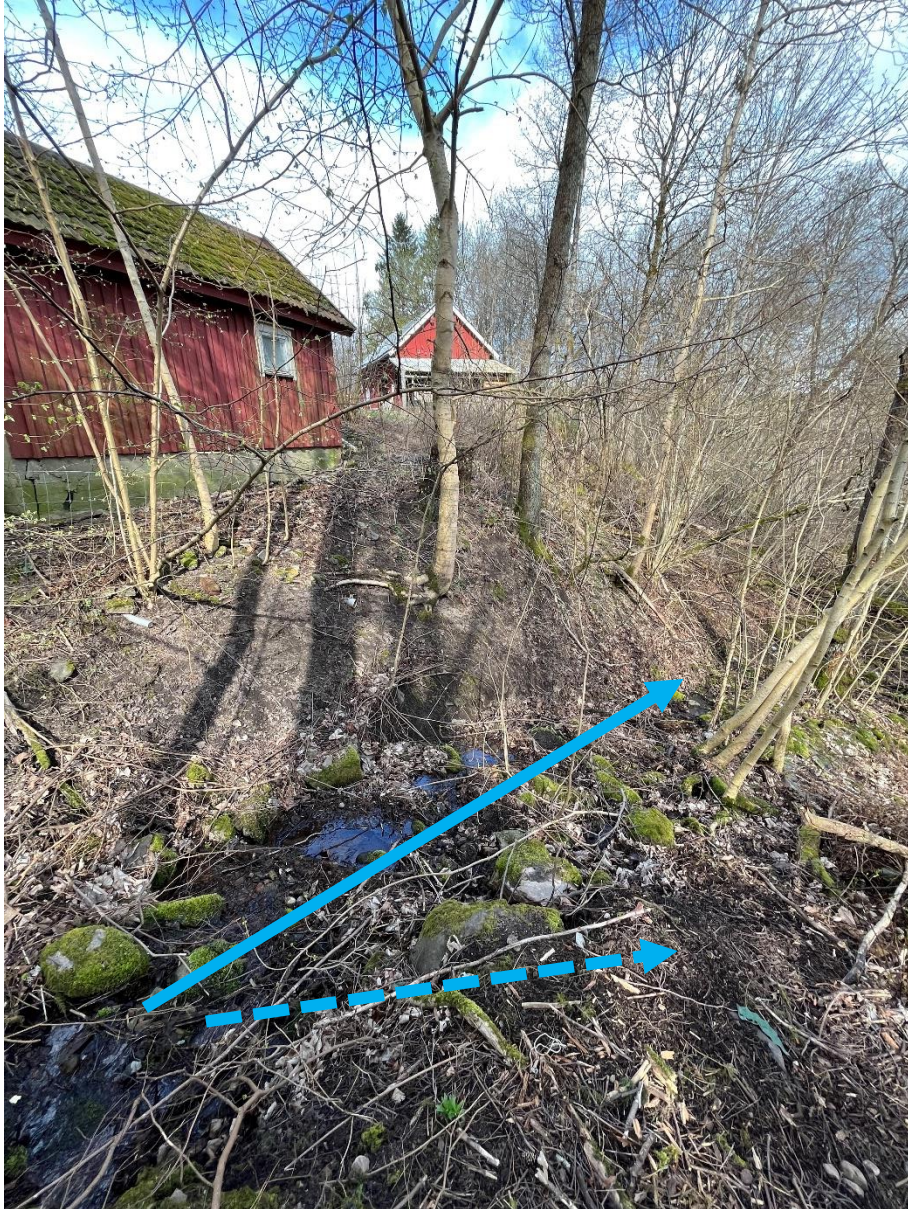
Dagvattnet rinner vidare norrut mot Viskan. Vid stora flöden finns öster om rinnvägen en damm (torrlagd vid platsbesök).
