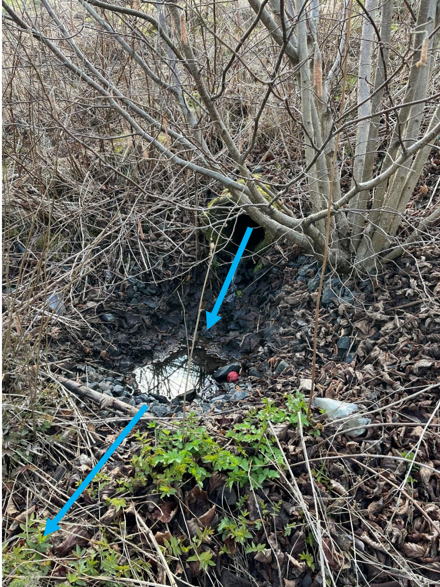
Dagvattnet rinner ut genom trumman och infiltreras i utlagd sprängsten.
