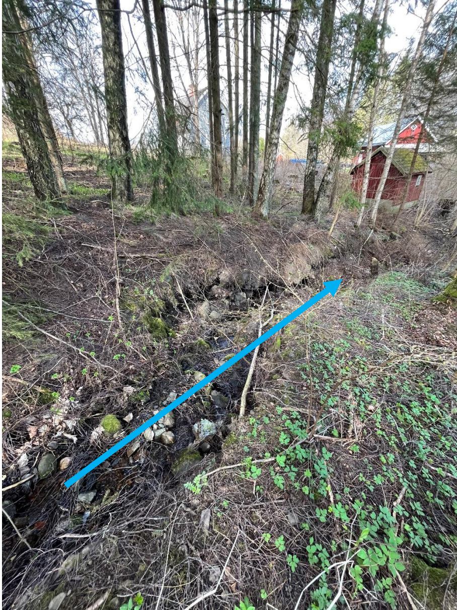
Tydliga tecken på erosion längs dagvattnets riktning mot Viskan.
