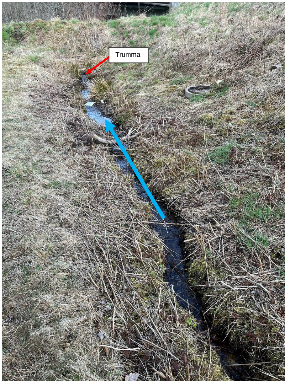
Dagvattnet rinner vidare längs befintligt dike och in i en trumma genom vallen längst bort i bild.
