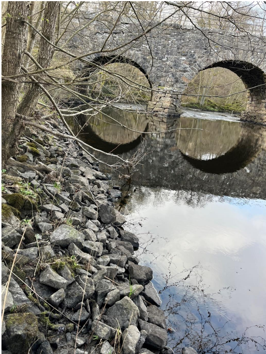
Erosionsskydd finns utlagt längs Viskans strand.
