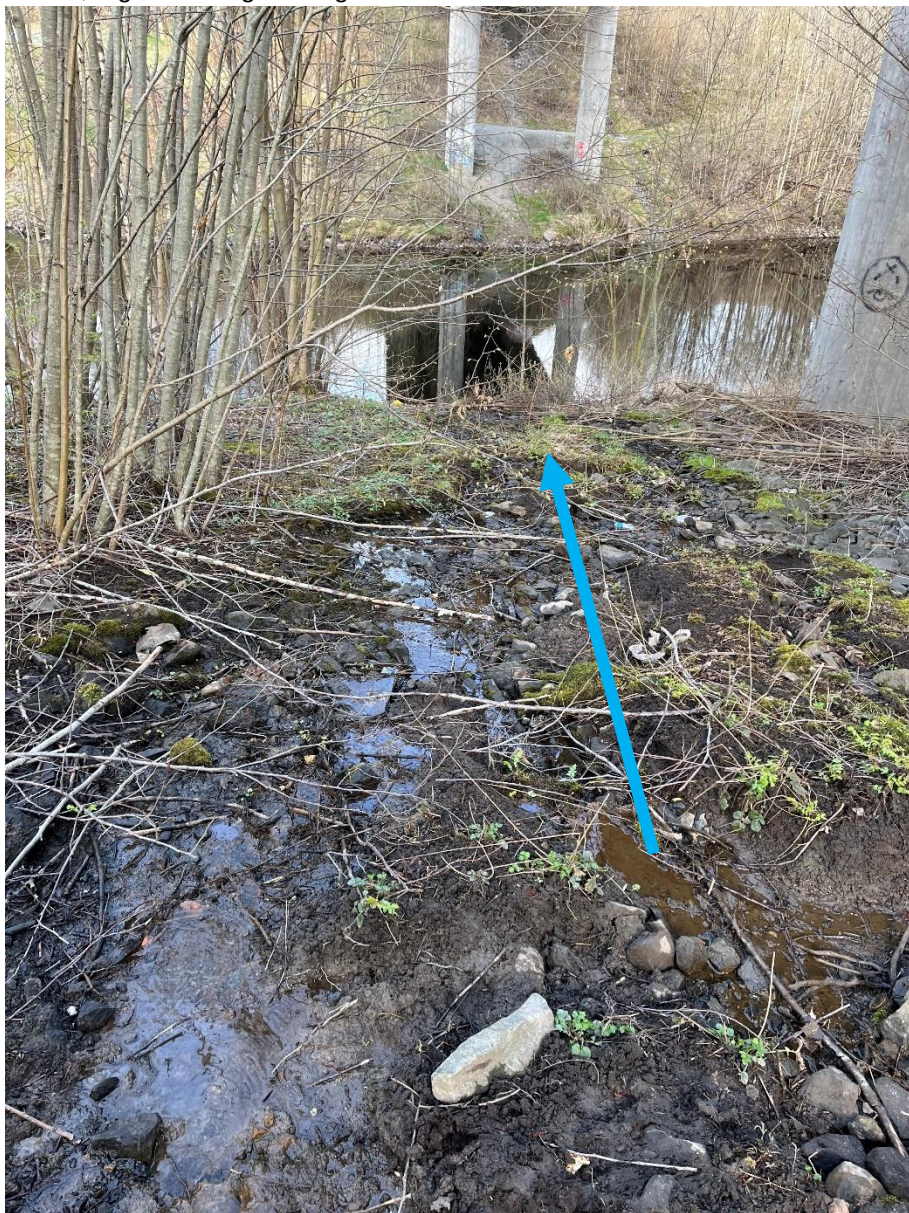
Dagvattnet rinner ner norrut mot Viskan. Stora delar av erosionsskyddet (utlagd sprängsten) är borta.
