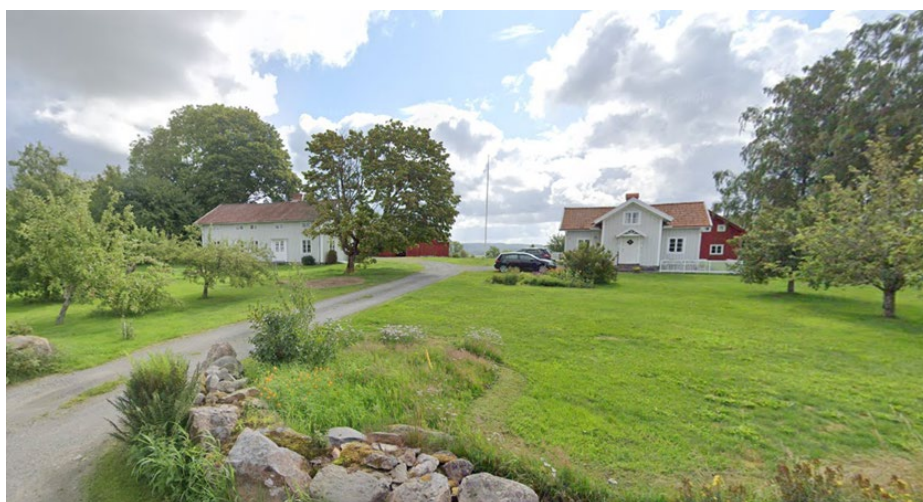
Figur 19 - Stommen vid Kantorns väg som ligger intill planområdet. Bostadshuset t.v. i bild uppfördes 1847 och huset t.h. 1905. Foto: Google maps, 2023.
