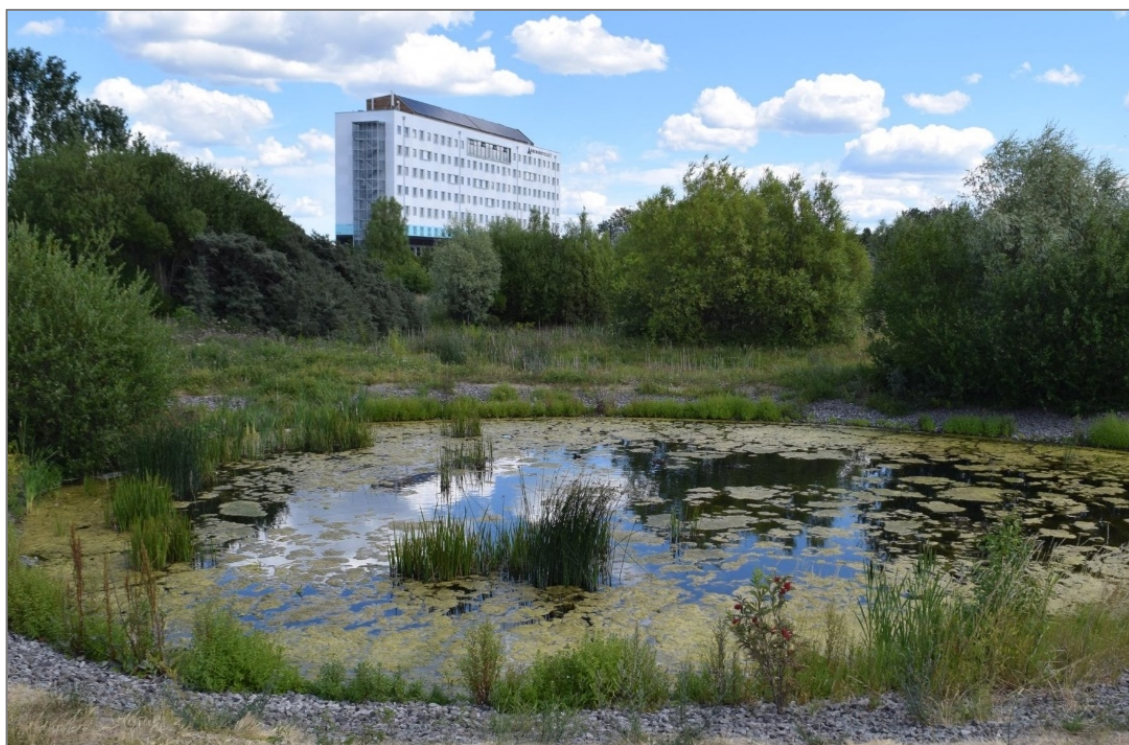
Figur 22- Exempel på dagvattendamm i Uppsala (Sveriges radio).
