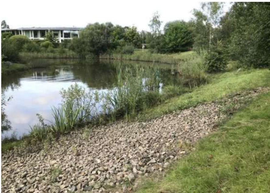
Figur 20 Dagvattendamm, Kungshultsvägen, Helsingborg. Foto: Jesper Persson (Kretslopp och vatten, Göteborgs stad)
