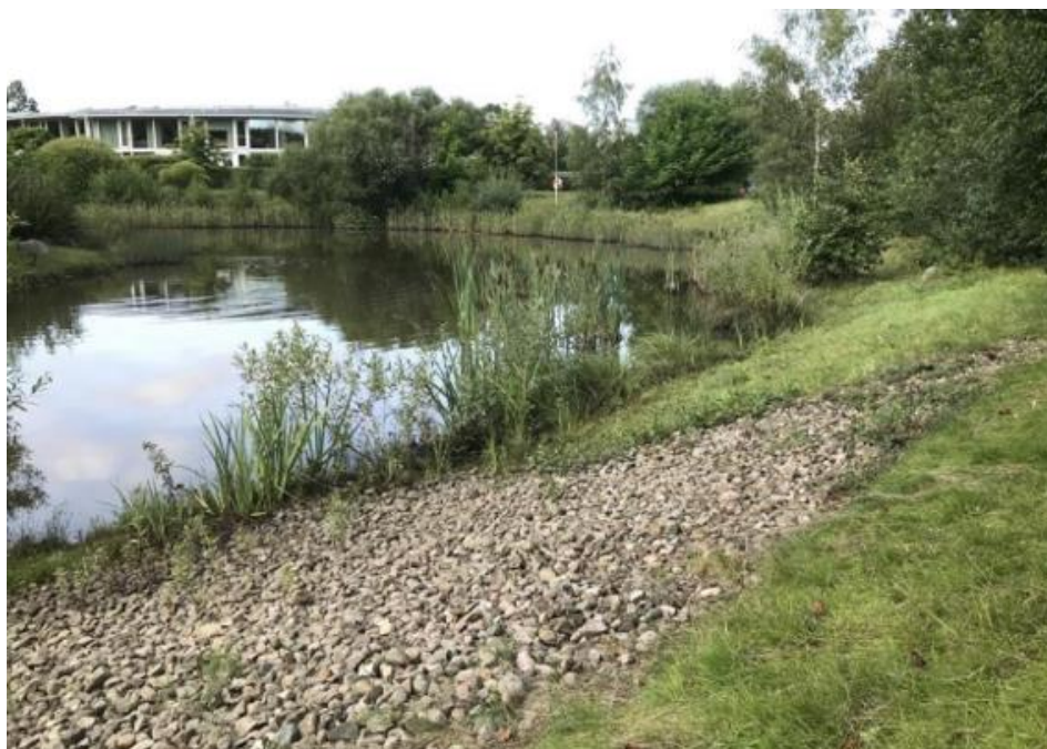
Figur 21 Dagvattendamm, Kungshultsvägen, Helsingborg. Foto: Jesper Persson (Kretslopp och vatten, Göteborgs stad)
