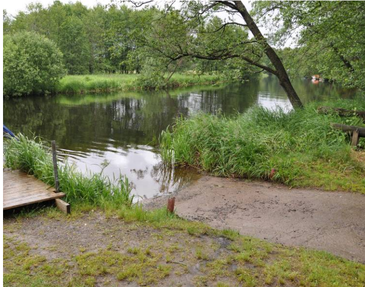
Figur 12. Iläggningsrampen som används av småbåtshamnens medlemmar.
