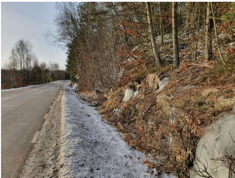
Figur 7. Bild tagen från söder åt norr på den västra sidan om Fjäråsvägen. Planområdet ligger således till vänster utanför bilden. I bilden syns vågdiket som därtill avleder dagvatten som avrinner från skogspartiet.
