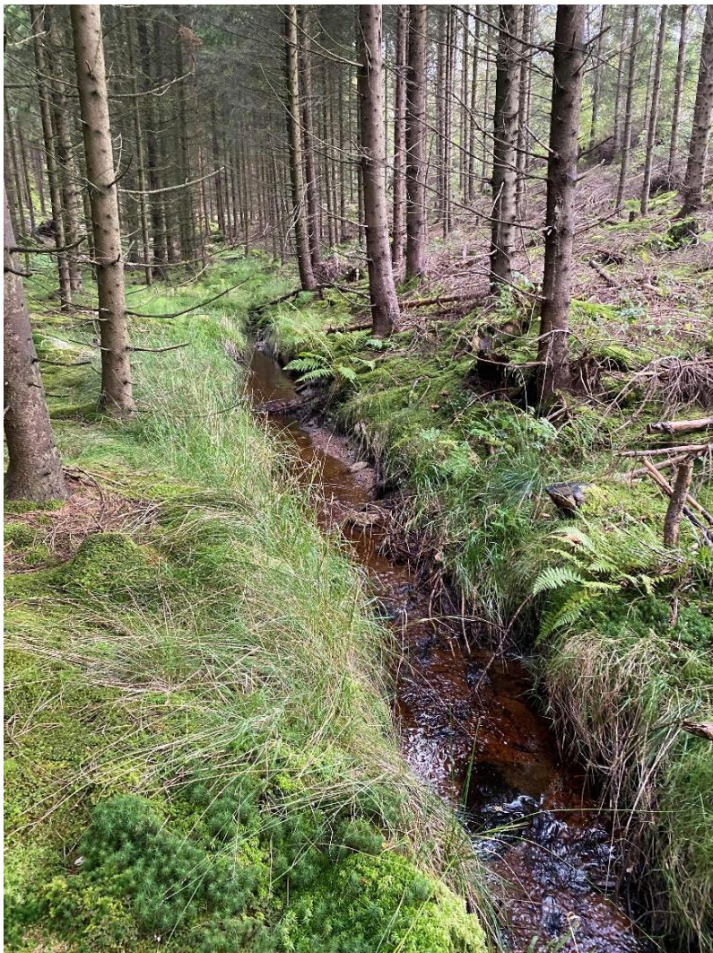
Figur 11. Naturligt dike som går genom planområdet. Diket leder avrinnande dagvatten från omgivande naturmark genom den norra trumman (BTG 800 mm) in i planområdet och sen genom den södra trumman (BTG 600 mm) ut från planområdet. Bilden tagen under platsbesök 2021-09-27.
