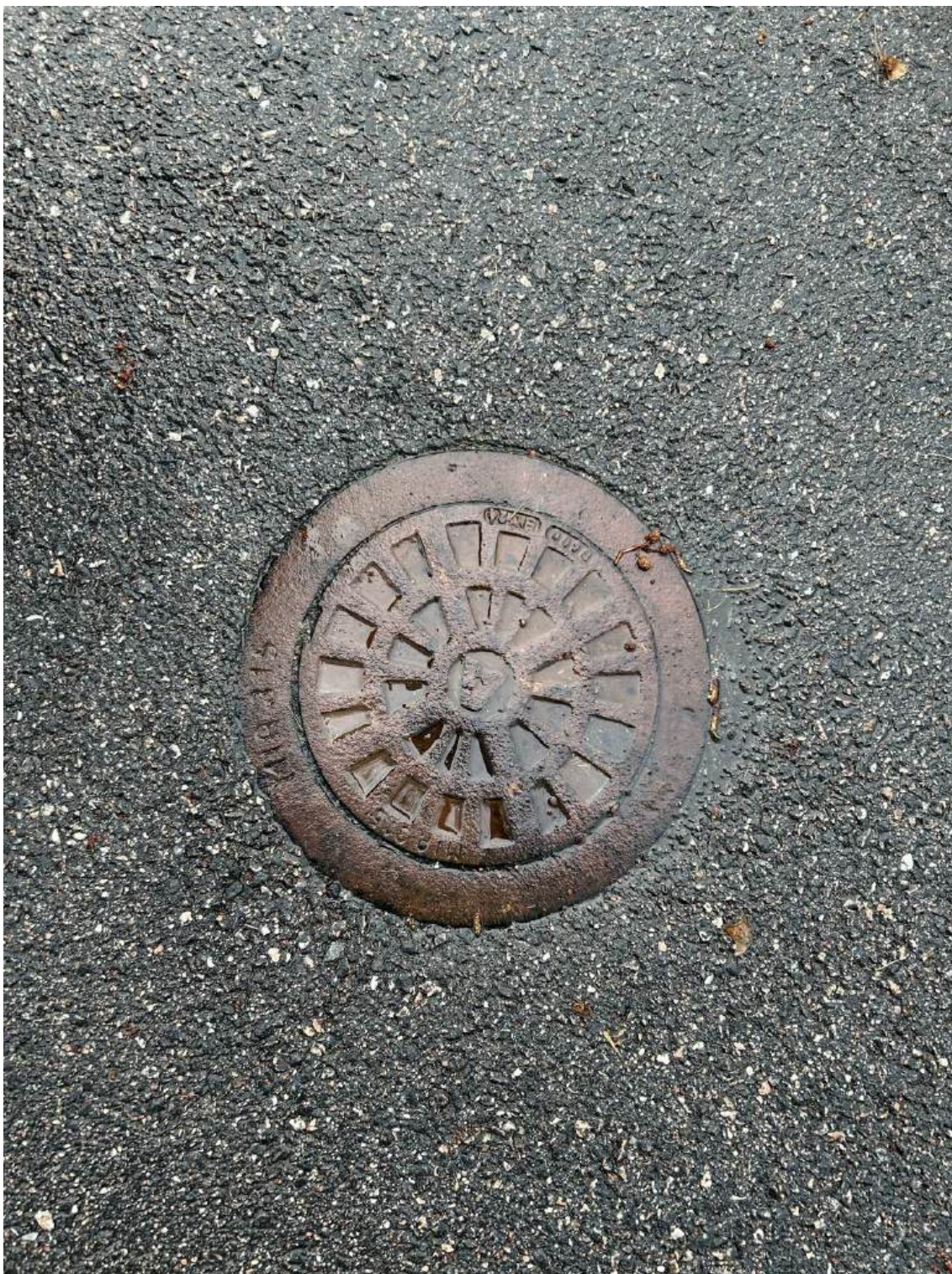
Figur B6: En avloppsbrunn (A-brunn) har identifierats vid Gång- och cykelvägen, intill fördröjningsdammen.
