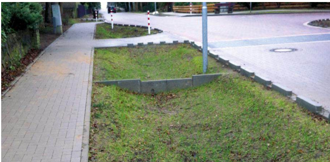
Figur 26 - Exempel på Svackdike med flödesreducerande hinder. Foto: Stockholms Vatten och Avfall
