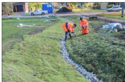
Figur 12. Svackdike med kross i botten samt illustration på dike med förhöjd kupolsil.
