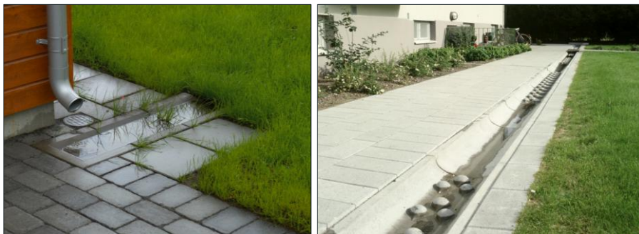
Figur 10. Vattenutkastare och dagvattenrännor, bilder från steriks.se.
