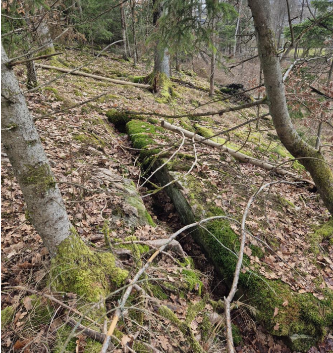
Figur 6.4 Slänt ovanifrån, block som lossat längs med brantstående spricka.
