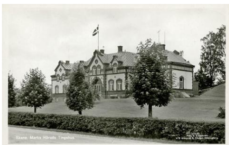
Figur 7: Tingshuset 1955, med flyglar.
