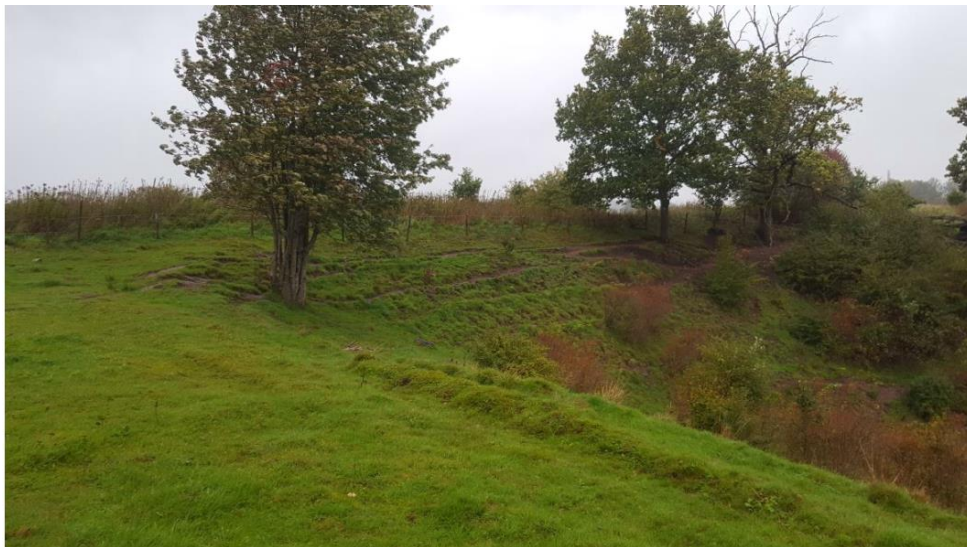
Figur 2 – Slänten ner mot Viskan med befintlig spillvattenledning i en vall vid släntkrön. Foto mot norr.
