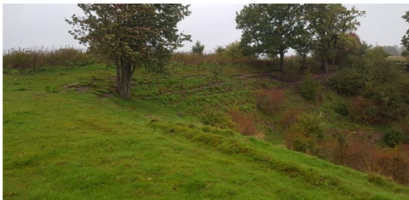
Figur 5. Slänten ner mot Viskan med befintlig spillvattenledning i en vall vid släntkrön. Foto mot norr. (Källa: Tyréns)
