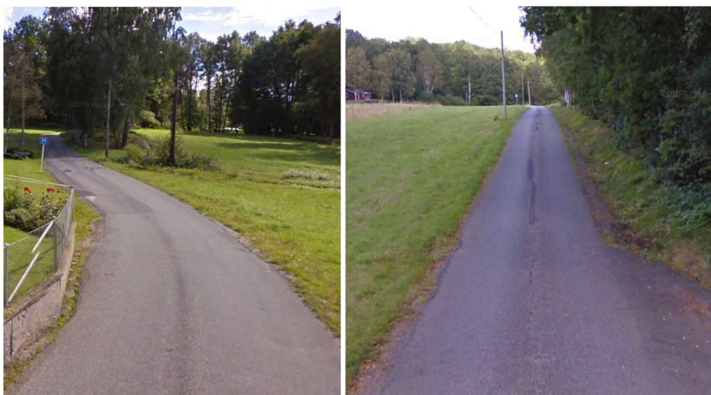
Foto över Kalvviksvägen. Till vänster del av vägsträckan från planområdet och ut mot den västra anslutningen till väg 156 och till höger del av vägsträckan från planområdet och ut mot den östra anslutningen till väg 156.
