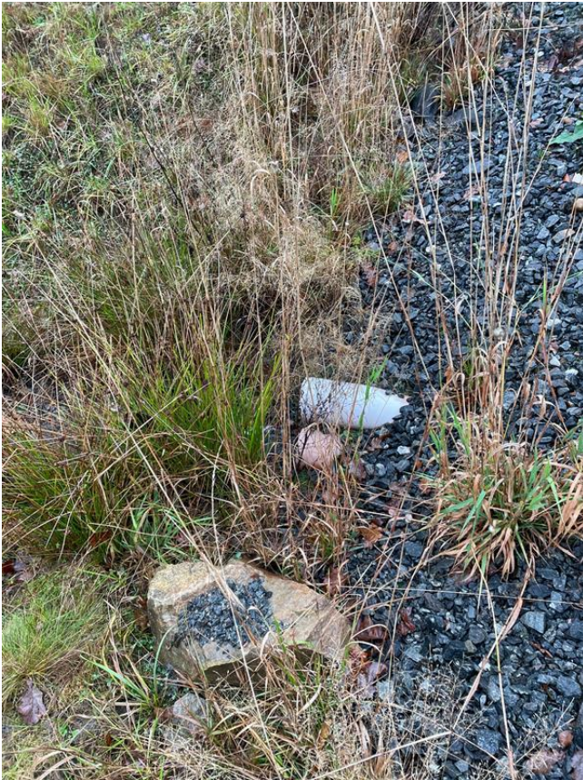
Figur 7. Plaströr som leder vatten under grusvägen vid planområdets norra gräns
