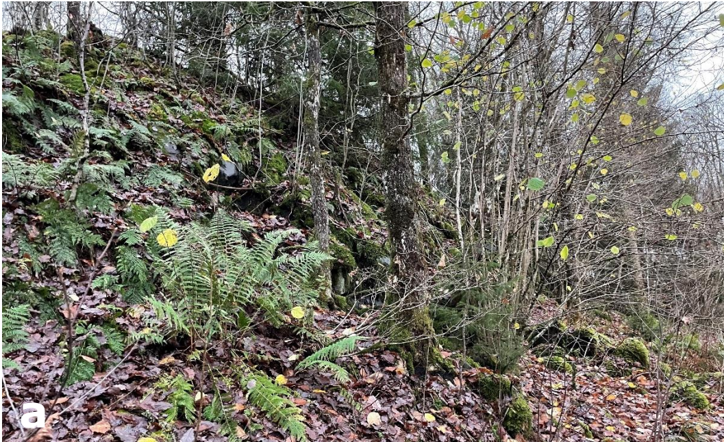
Figur 1-2. Område 1. Vy mot SO. Slänt mot naturmark. Ytor generellt täckta av mossa/tunt lager mulljord. Synliga block har generellt stöd i underkant, enstaka block med begränsat stöd i underkant bedöms förekomma, se figur 1-3. Sannolikheten för utfall bedöms generellt vara låg.
