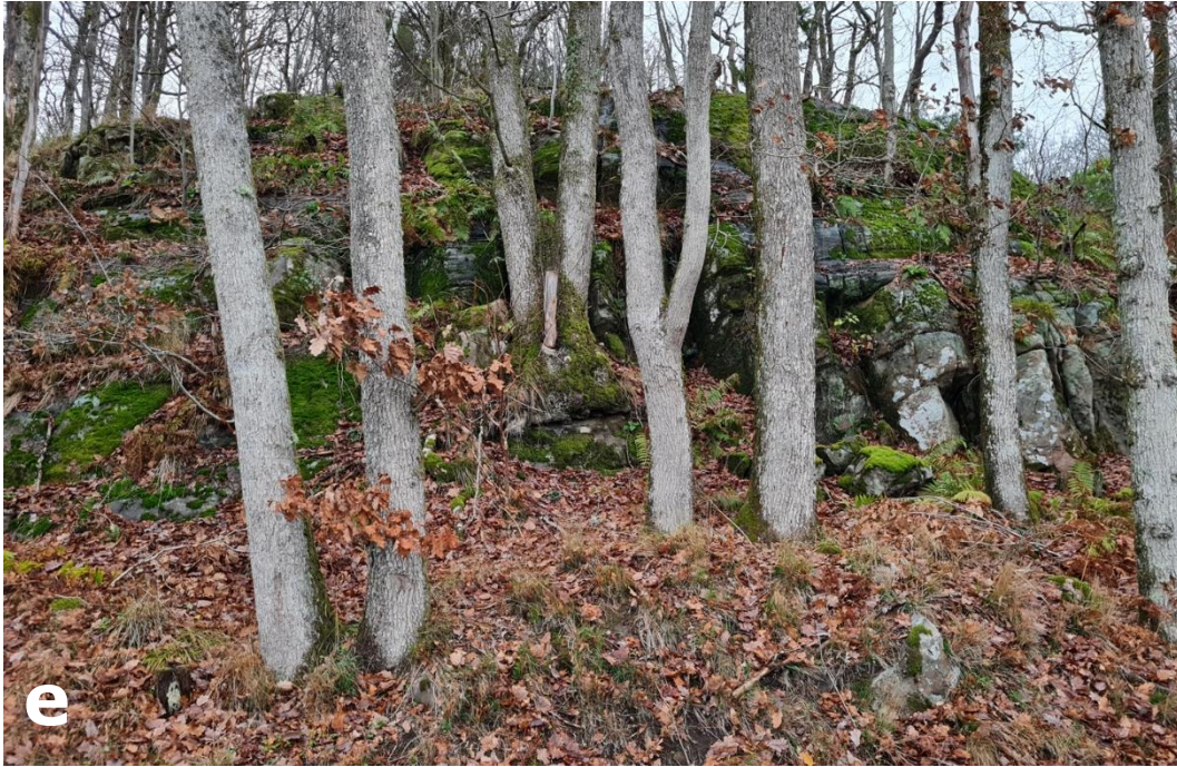
Figur 1-8. Område 2. Slänt mot Kalvviksvägen. Vy mot N. Block vilar generellt på subhorisontella sprickplan varför sannolikheten för utfall bedöms vara låg för befintliga förhållanden. Nedtagning alternativt förankring av enstaka block kan bli nödvändigt i samband med markarbeten/berguttag.
