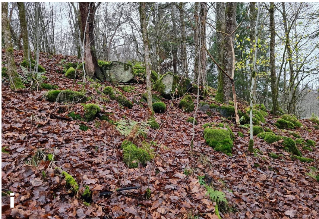
Figur 1-16. Område 3. Vy mot NO. Stenar och block. Slänten bedöms stabil för befintliga förhållanden.
