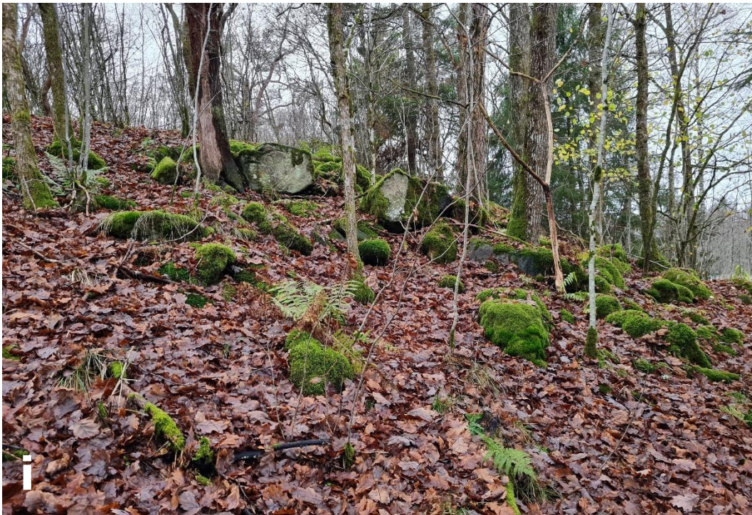
Figur 1-14. Område 3. Vy mot NO. Lösa stenar och block. Slänten bedöms stabil för befintliga förhållanden.
