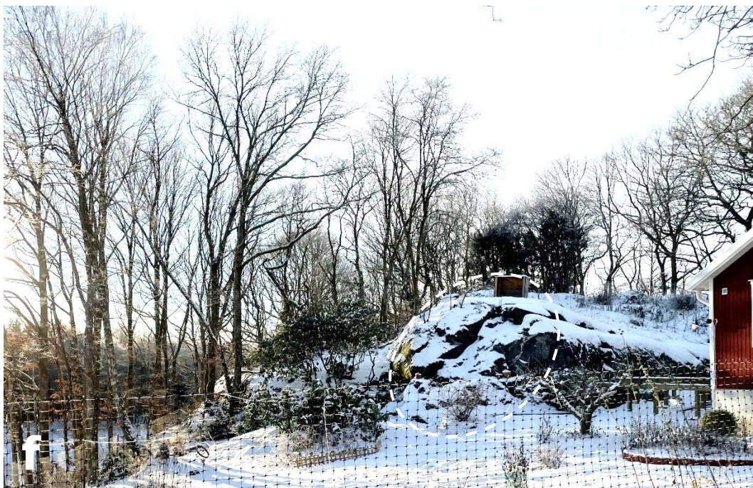
Figur 1-10. Område 2. Bergslänt in mot angränsande fastighet. Parti med potentiellt lösa/instabila block redovisas med vit, streckad linje. Bergslänten mot angränsande fastighet bör synas före markarbeten/berguttag för att avgöra lämplig åtgärd. Se även Google maps street view (länk).
