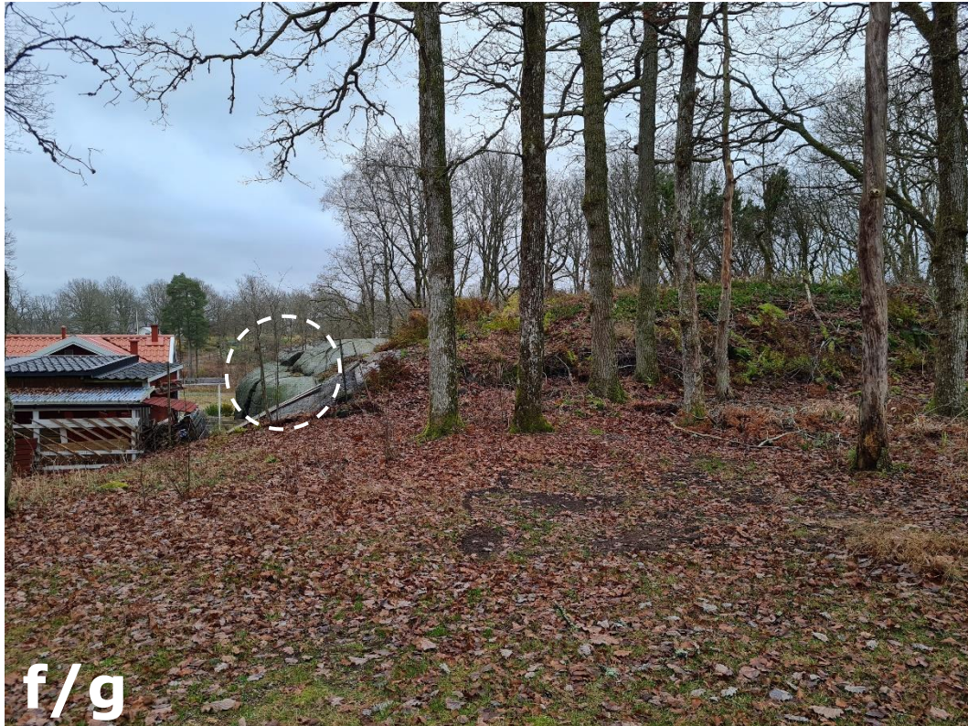
Figur 1-11. Område 2. Vy mot S. Till vänster i bild, bergslänt på angränsande fastighet. Parti med potentiellt lösa/instabila block redovisas med vit, streckad linje. Bergslänt mot angränsande fastighet bör synas före markarbeten/berguttag för att avgöra lämplig åtgärd.
