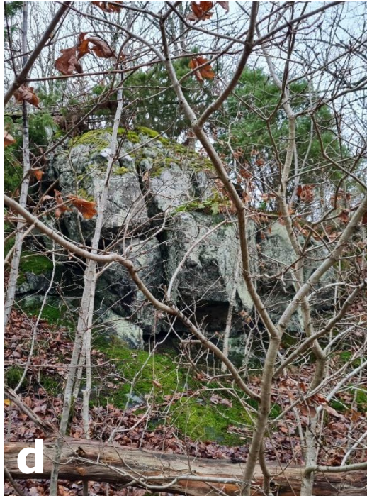
Figur 1-6. Område 1. Slänt mot Kalvviksvägen. Vy mot N respektive O . Parti med större block staplade på varandra. Block vilar på glidyta med stupning ca 40° ut mot Kalvviksvägen. Block bör rensas/tas ned alternativt förankras i bakomliggande, stabilt, berg
