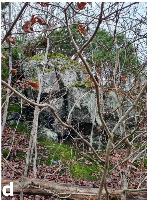
Figur 1-7. Område 1. Vy mot N respektive O. Slänt mot Kalvviksvägen. Parti med större block staplade på varandra. Block vilar på glidyta med stupning ca 40° ut mot Kalvviksvägen. Sannolikhet för utfall bedöms som måttlig. Block bedöms kunna nå vägbana vid utfall. Block bör rensas/tas ned alternativt förankras i bakomliggande, stabilt, berg.
