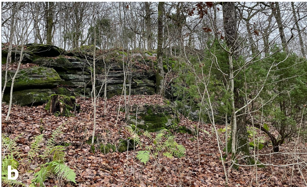
Figur 1-4. Område 1. Vy mot N. Slänt mot Kalvviksvägen. Överhäng förekommer. Överhäng (skivor) vilar generellt på subhorisontella ytor (foliationsplan), varför sannolikheten för utfall bedöms vara mycket låg.
