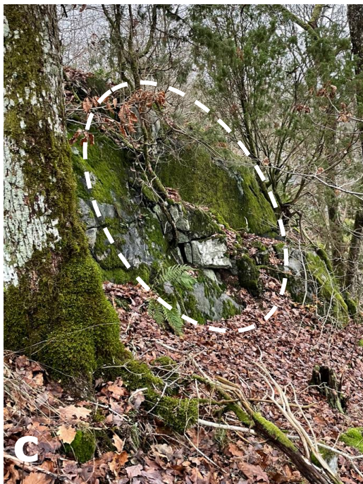
Figur 1-6. Område 1. T.v. Detaljbild potentiellt instabila block. Block strax under släntrönn. Block vilar på subhorisontella ytor och bedöms i nuläget stabila, vegetation i bakkant kan medföra framtida instabilitet. Vegetationsrensning och rensning av lösa block rekommenderas. T.h. Detaljbild potentiellt instabila block. Lösa block på sluttande yta ut mot Kalvviksvägen, rensning av lösa block rekommenderas.
