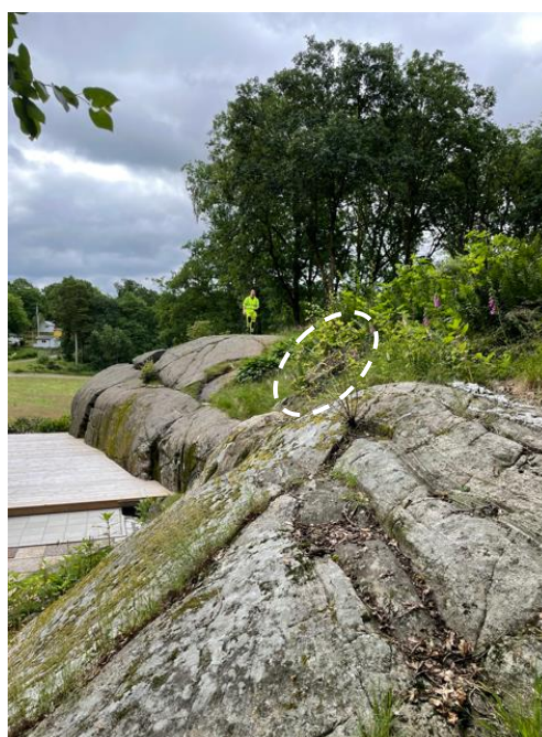
Figur 1-13. Område 2. Vy mot S. Bergslänt delvis belägen på angränsande fastighet. Block beläget vid fastighetsgräns redovisas med vid, streckad linje. Block bedöms stabilt för befintliga förhållanden men bör förankras om berguttag utförs i anslutning till slänt.
