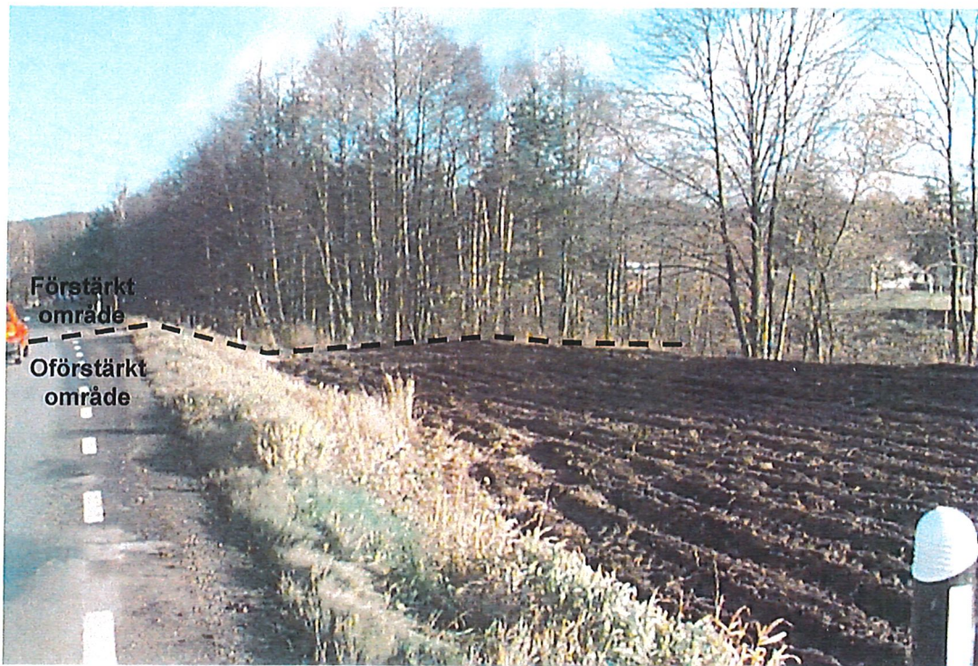
Bild 2 Gräns mellan förstärkt och oförstärkt område (Fotopunkt 3).
