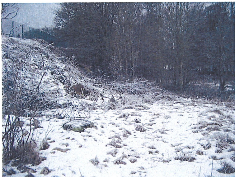
foto 1: slänt mot fastighet Lydde 1:13
