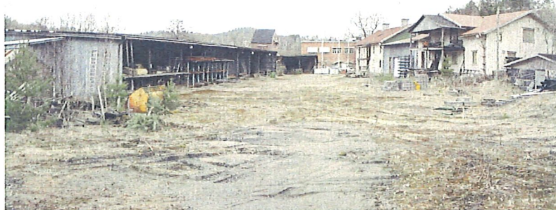
Foto 4: Del av befintlig bebyggelse (tidigare brädgård)
