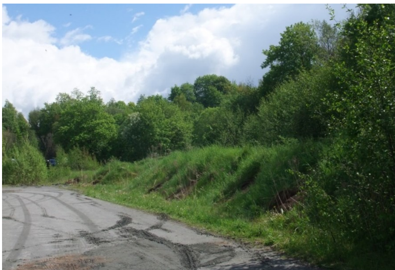
Figur 3. Vall av uppschaktat material.
