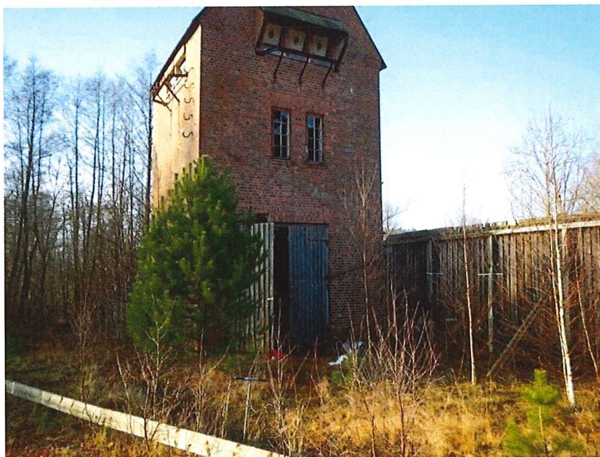
Figur 2. Området kring transformatorstationen består huvudsakligen av låg gräsvegetation.
