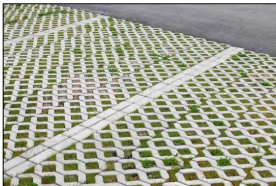
Figur 21. Exempel på rasterklädd parkeringsyta med gräs i hålrummen (Foto: Sweco).
