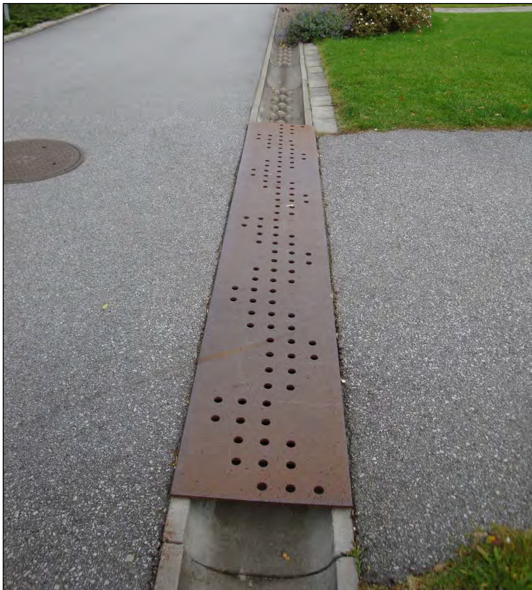
Figur 20. Exempel på stålplatta för att underlätta passage för fordon och fotgängare. Stålplattan kan utformas på många olika sätt för att passa designen i närmiljön (Foto: Sweco).
