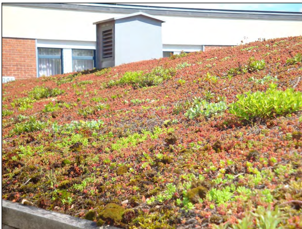
Figur 23. Exempelbild på ett grönt tak (Foto: Sweco).
