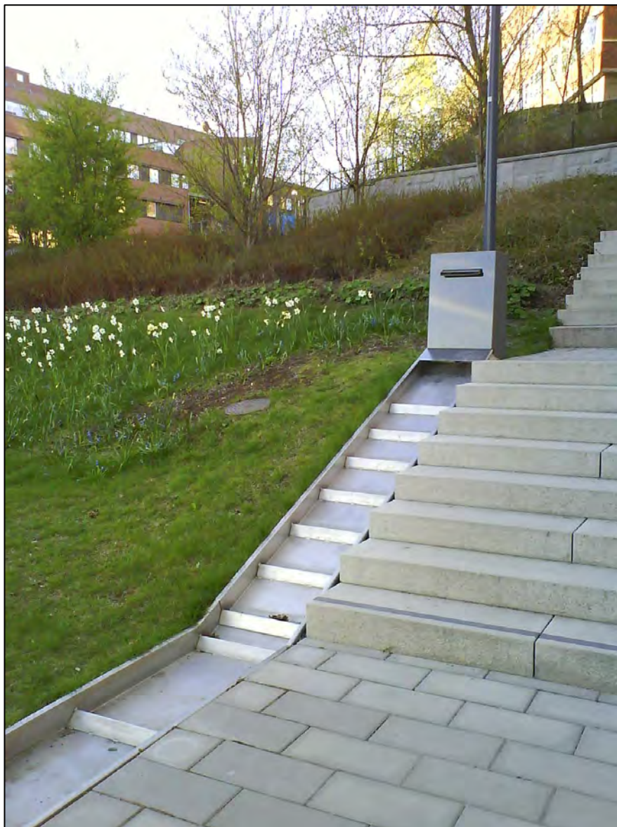
Figur 19. Exempelbild på trappa för avledning av dagvatten i slänt. Mindre magasineringsvolym och lägre estetiskt värde (Foto: Sweco).
