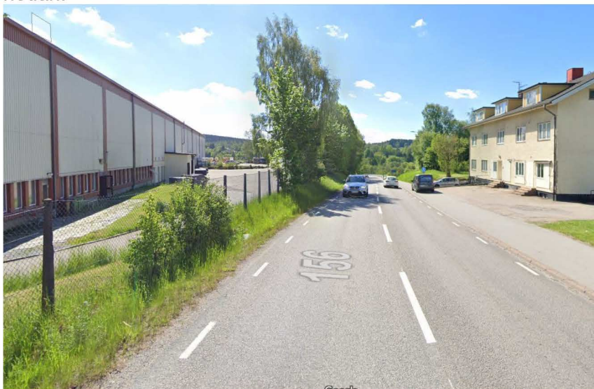
Figur 9 Foto i riktning söderut längs Väg 156. Till vänster i bild syns del av planområdet med befintlig byggnad (google.maps Streetview).
