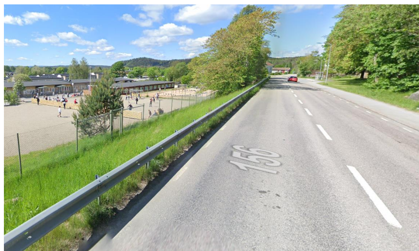
Figur 4. T.h. i figuren syns väg 156 och t.v. syns Tingvallaskolan. Mellan väg 156 och Tingvallaskolan finns en kraftig slänt.
