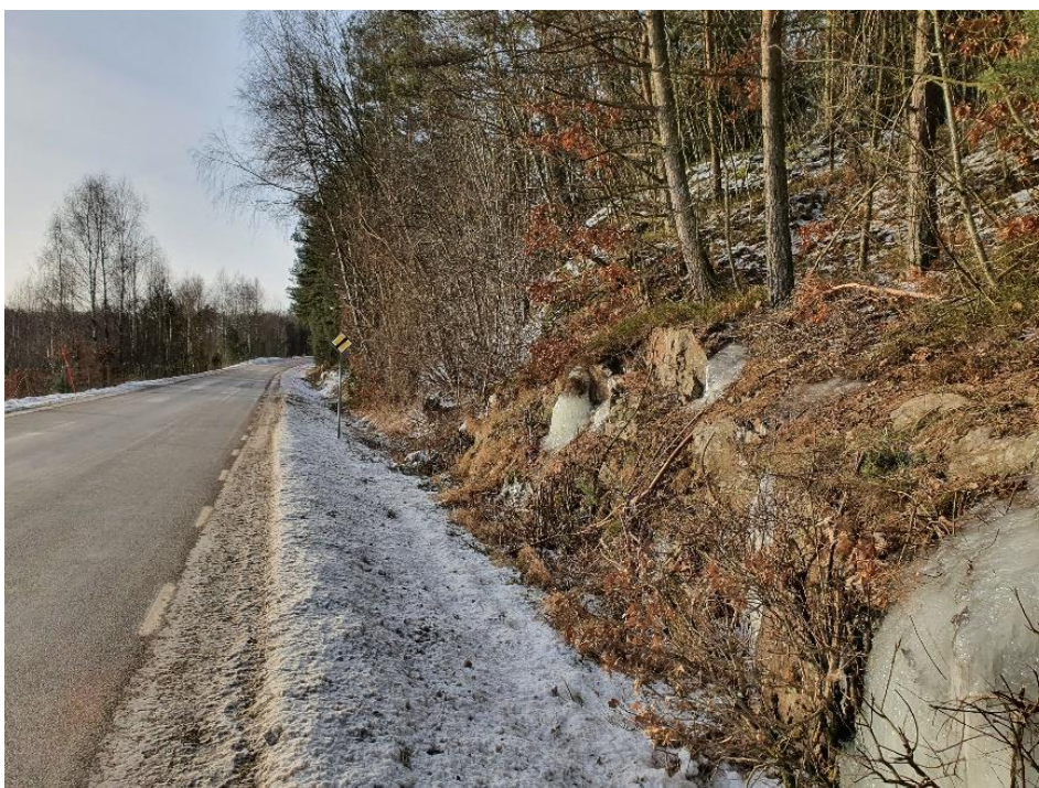
Figur 8. Bild tagen från norr åt söder på den västra sidan om Fjäråsvägen. Planområdet ligger således till vänster utanför bilden. I bilden syns vägdiket som därtill avleder dagvatten som avrinner från skogspartiet, mot 300 mm BTG-vägtrumman i Figur 7.
