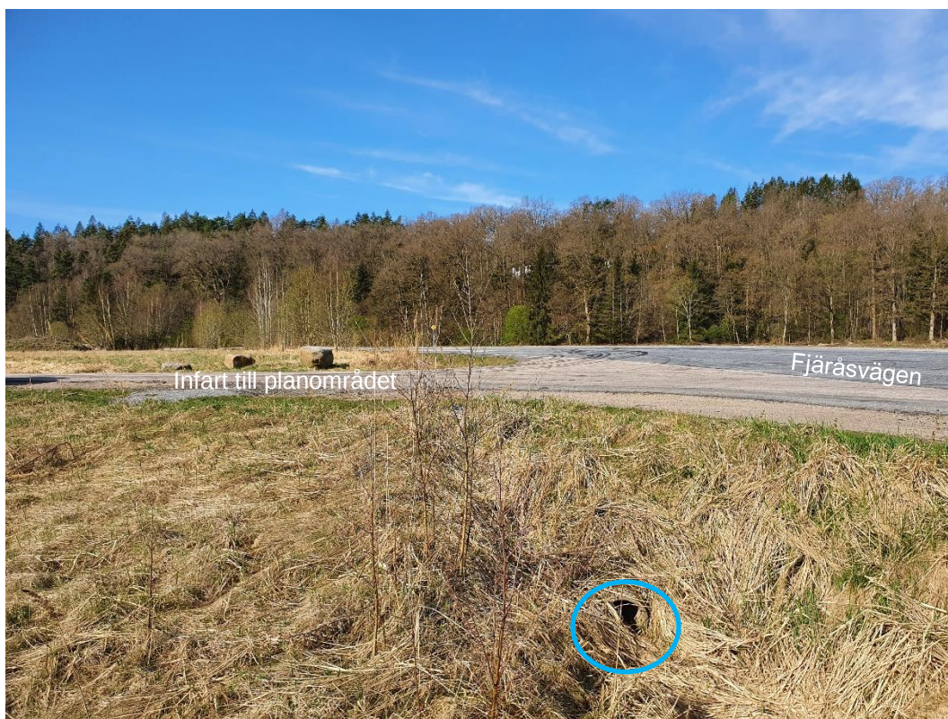
Figur 9. Bild tagen från öster åt väster på den södra sidan av Fjäråsvägen, med planområdet till vänster i bild. Inom blå markering visas 300 BTG-vägtrumma som avleder dagvattnet från vägdiket i planområdet nordvästra del till att ledas ut i Storån.
