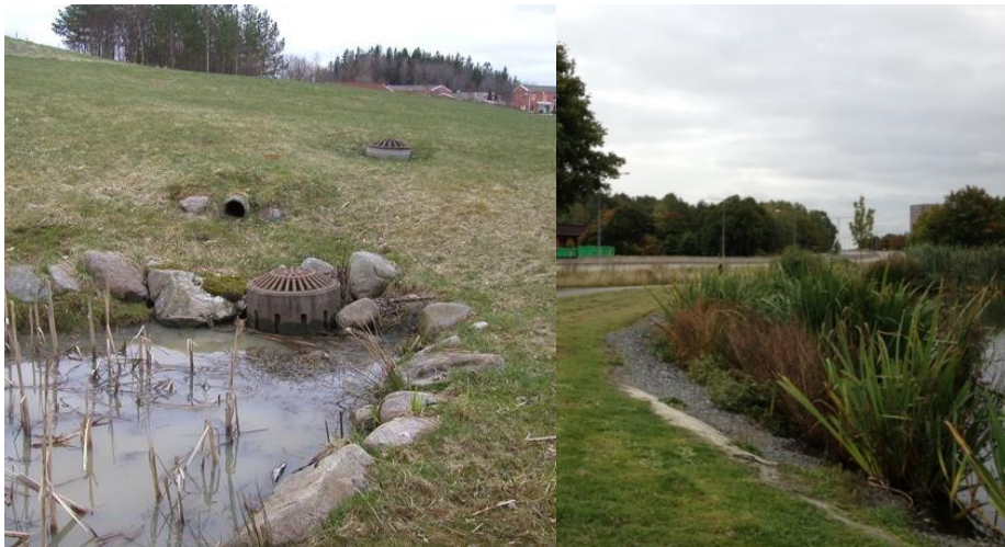
Figur 20. Exempelbilder dagvattendamm. (källa: Sweco)
