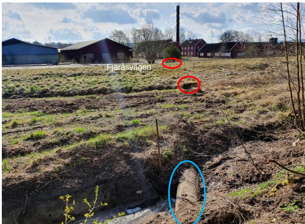
Figur 6. Bild tagen från öster mot planområdet i väster. Inom blå markering visas 500 mm BTG-ledning som förefaller leda mot planområdet, via de två betongbrunnarna (positioner markerade i rött) på var sida om Fjäråsvägen.
