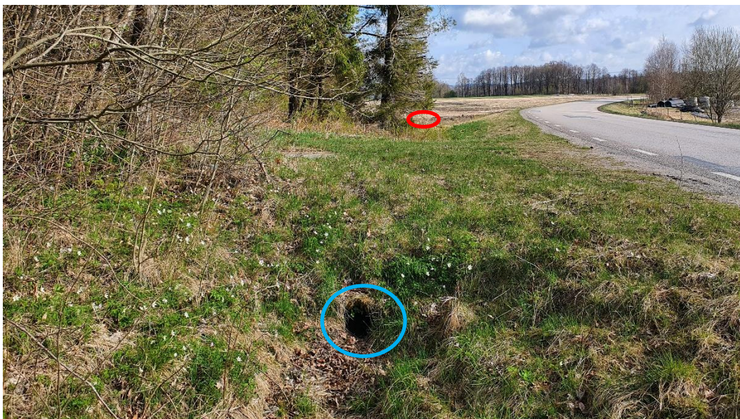
Figur 7. Bild tagen från söder åt norr på den västra sidan av Fjäråsvägen, med planområdet till höger utanför bild. Inom blå markering visas 300 mm BTG-vägtrumma som fortsätter avleda dagvattnet norrut till betongbrunnen (röd markering) och vägtrumman under Fjäråsvägen.
