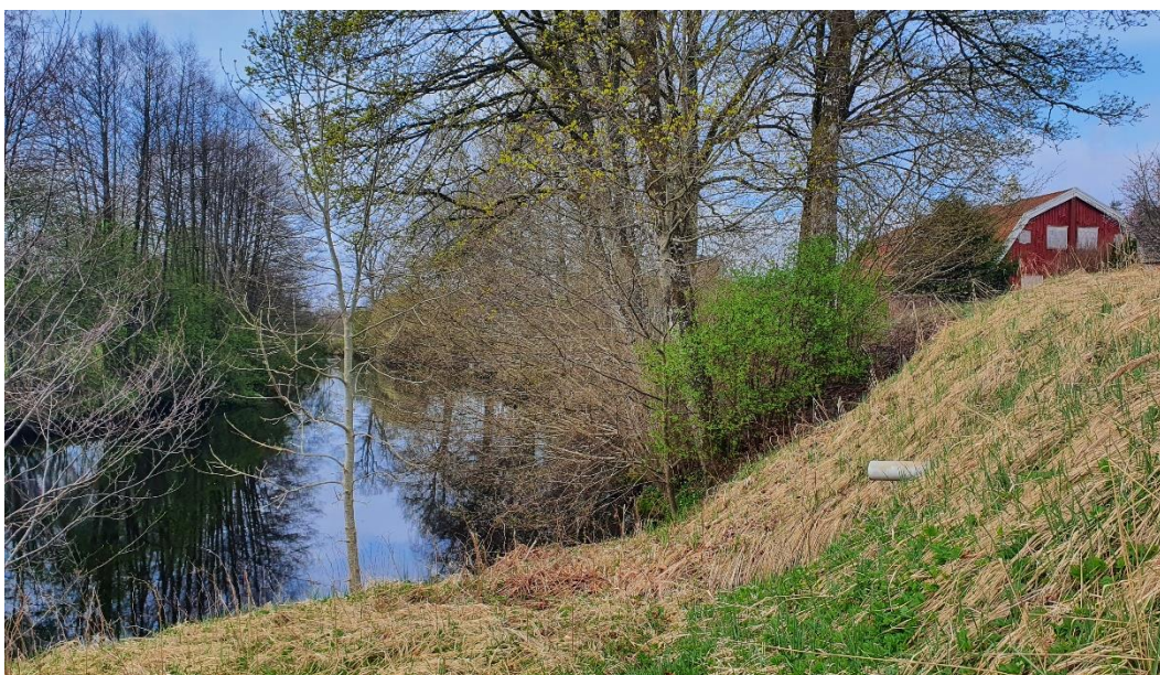
Figur 4. Bild tagen från norr åt söder över Storån. Till höger i bild, syns det möjliga utloppet från dagvattenledningarna samt den branta slänten från planområdet ner mot Storån.
