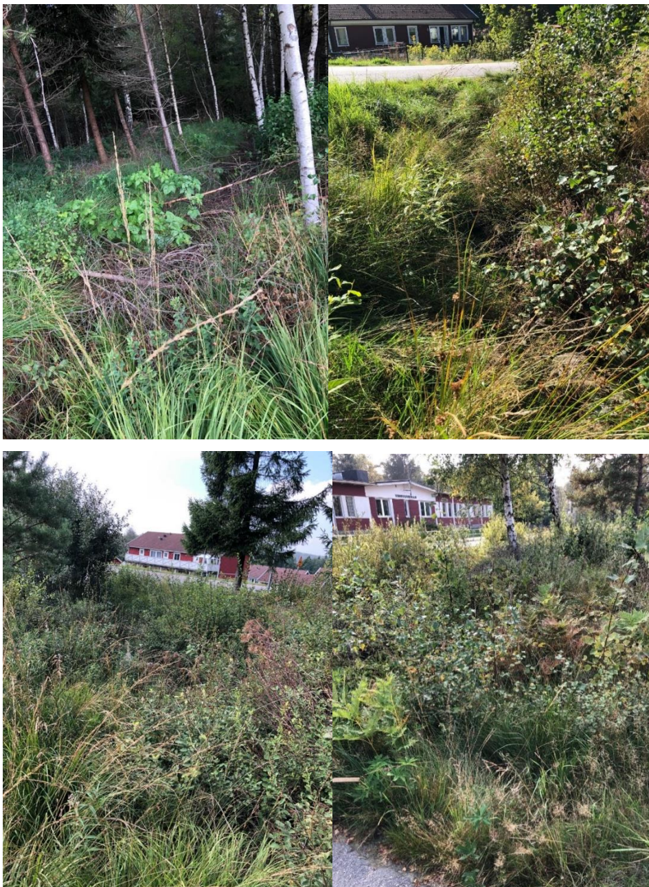
Figur 6. Bilder som redovisar dike väster om skolbyggnad. Löper från norr till söder.
