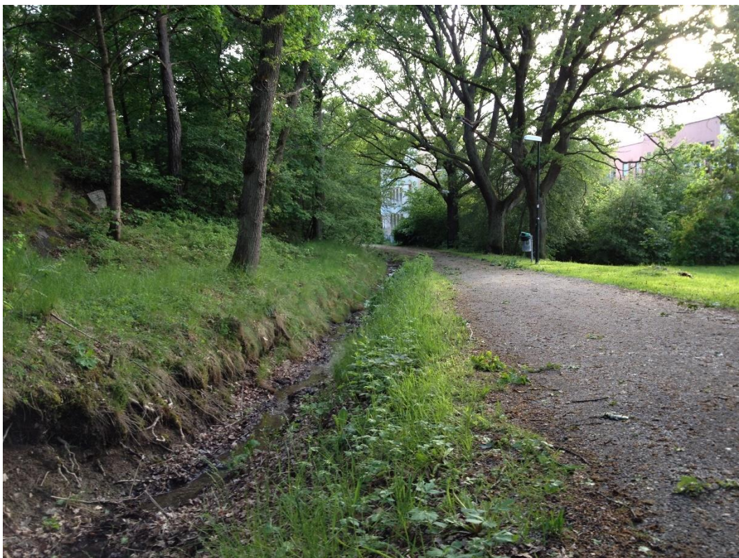
Figur 15. Exempel på gräsdike intill väg (Källa: Sweco).
