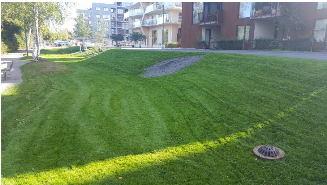
Figur 17. Exempel på fördröjningsdamm vid torra väderförhållanden (Källa: Sweco).
