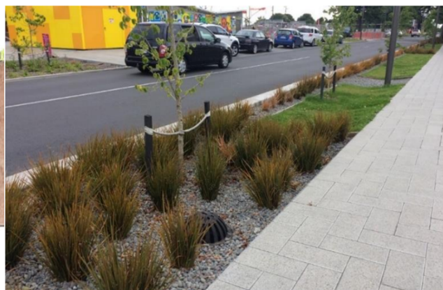
Figur 14 - T.v. principritning för ett makadamdike. T.h. exempel på ett makadamdike ihop med olika växtlighet.
