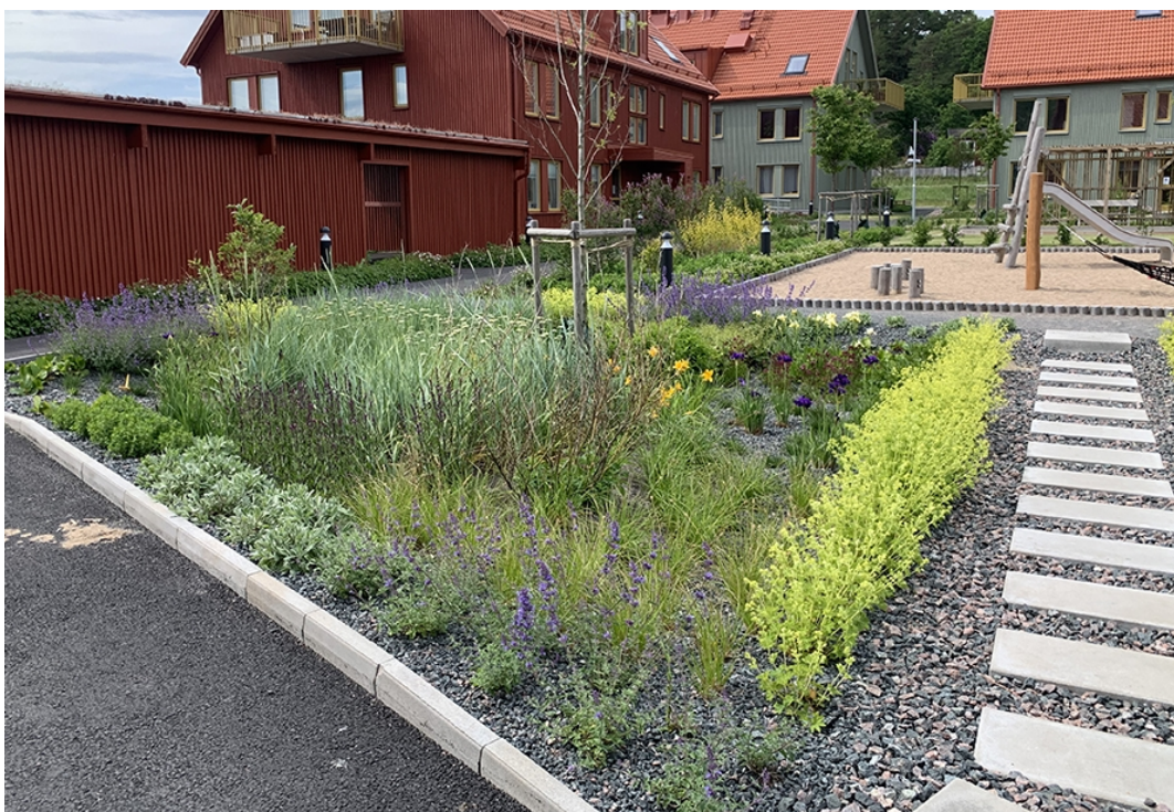
Figur 11 - Biofilteranläggning/Regnträdgård med planteringar med växtbäddar och krossmaterial (Hasselfors garden, 2023).
