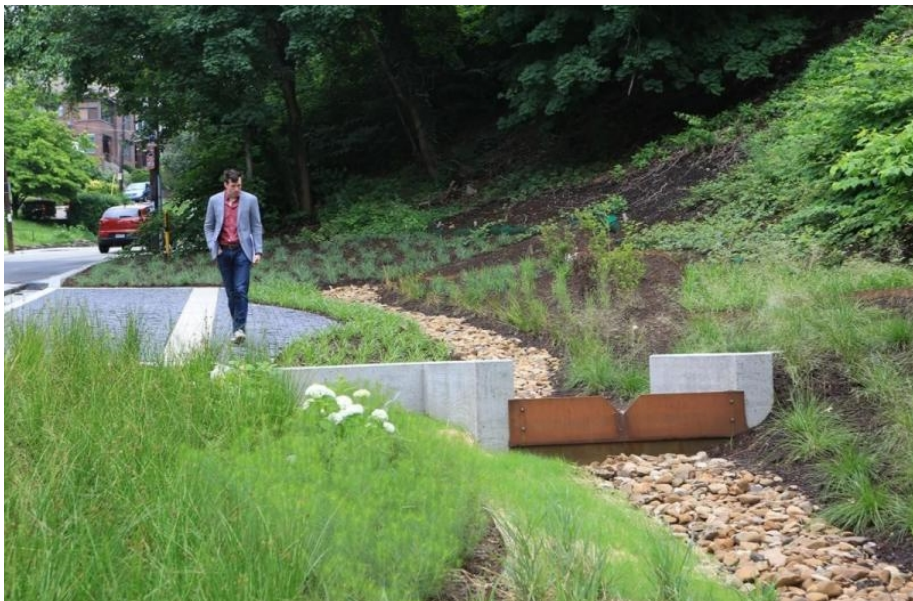
Figur 23 - Sektionerat dike i olika nivåer med en skiva som kan flödesreglera dagvattenflödet i Pittsburgh, USA (PGH20, 2023).
