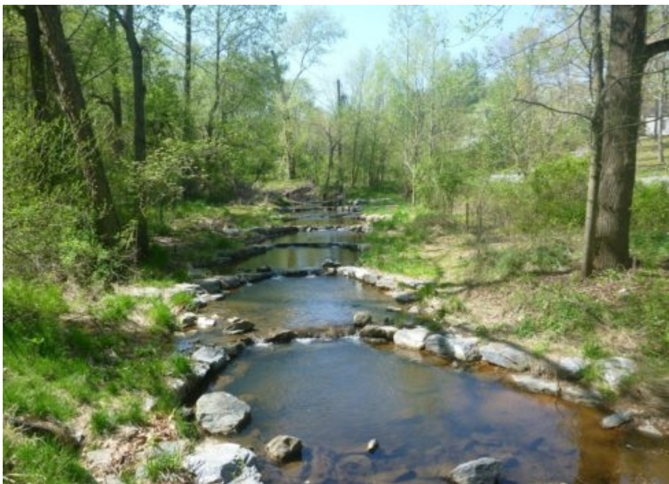
Figur 21 – Vattentrappa i en mer naturlig utformning utanför Philadelphia, USA (Montgomery County, MD, 2023).
