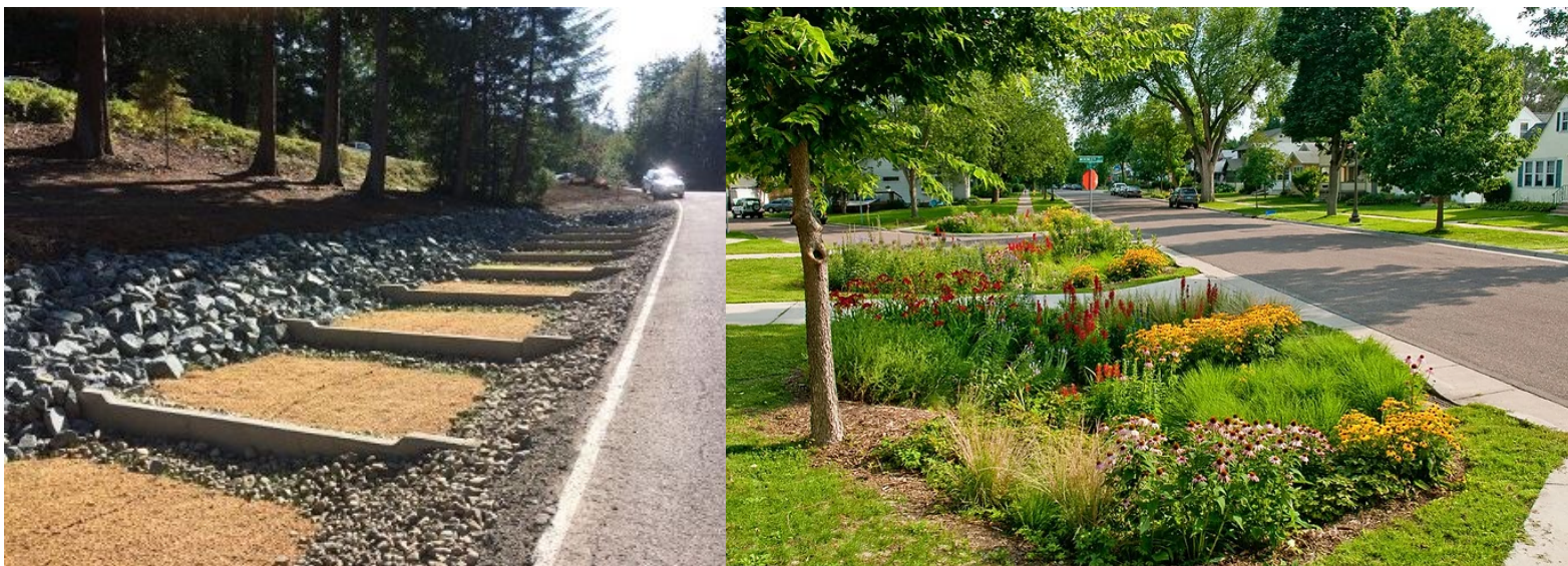
Figur 25 - T.v. sektionerat dike med olika fraktion kross, (Whatcom County, 2023). T.h. växtlighet i ett mindre dagvattendike som visas för att ge en känsla av hur sektionerna i diket skulle kunna anläggas med växtlighet (Stormwater Innovation Center, 2023).
