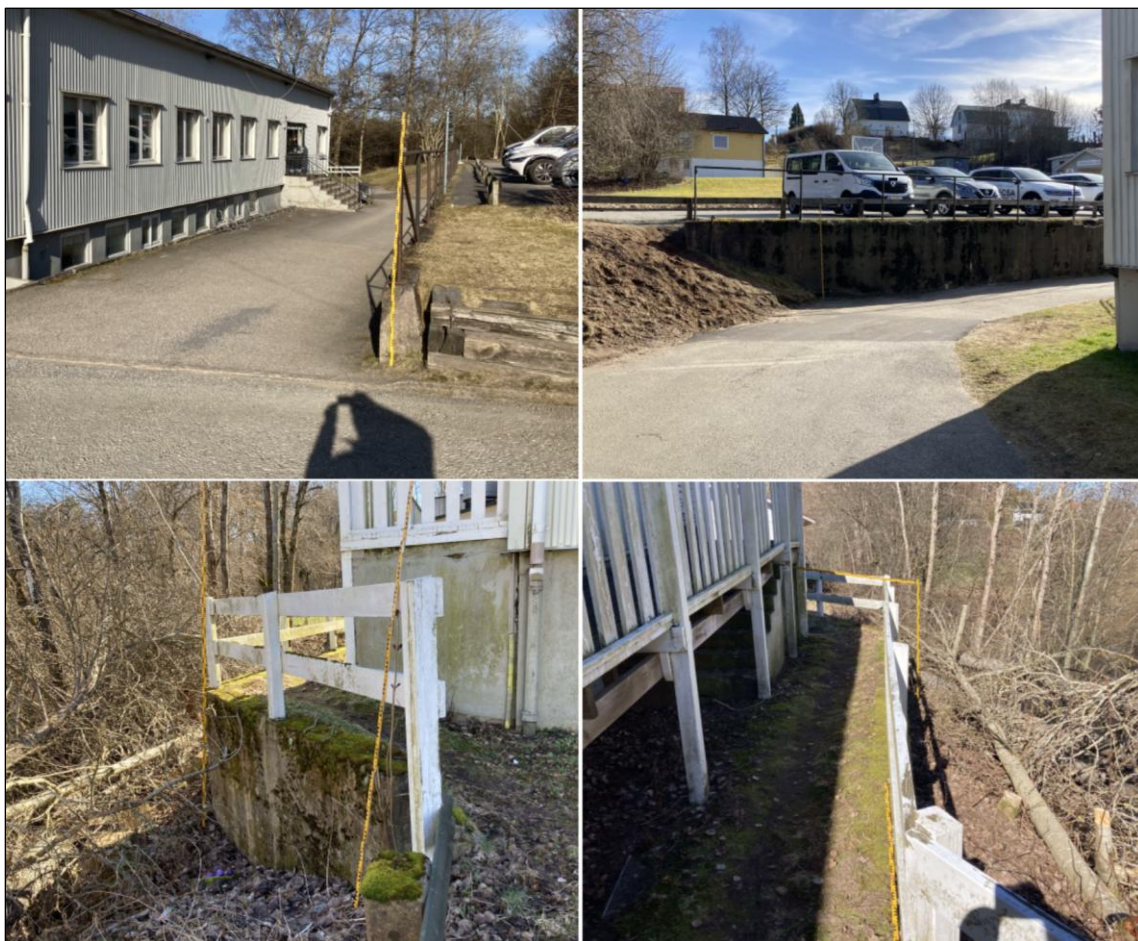
Figur 6: De övre fotografierna visar befintlig stödmur mellan parkeringsplats samt södra kortsidan av Kinnahallen. De nedre fotografierna visar befintlig stödmur mellan östra sidan av Kinnahallen och Viskan.
