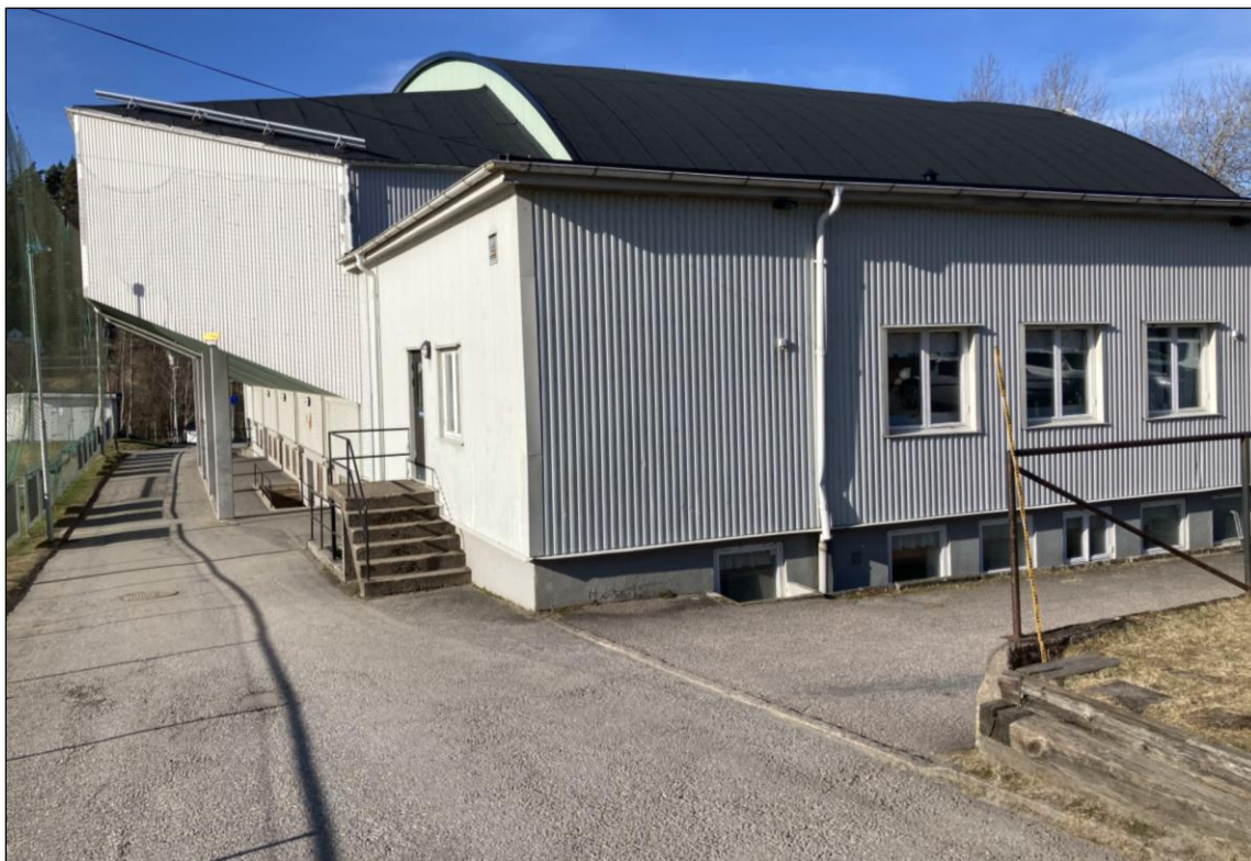
Figur 5: Foto taget söder om Kinnahallen, figuren visar del av idrottshallen samt tillbyggnation på västra långsida.
