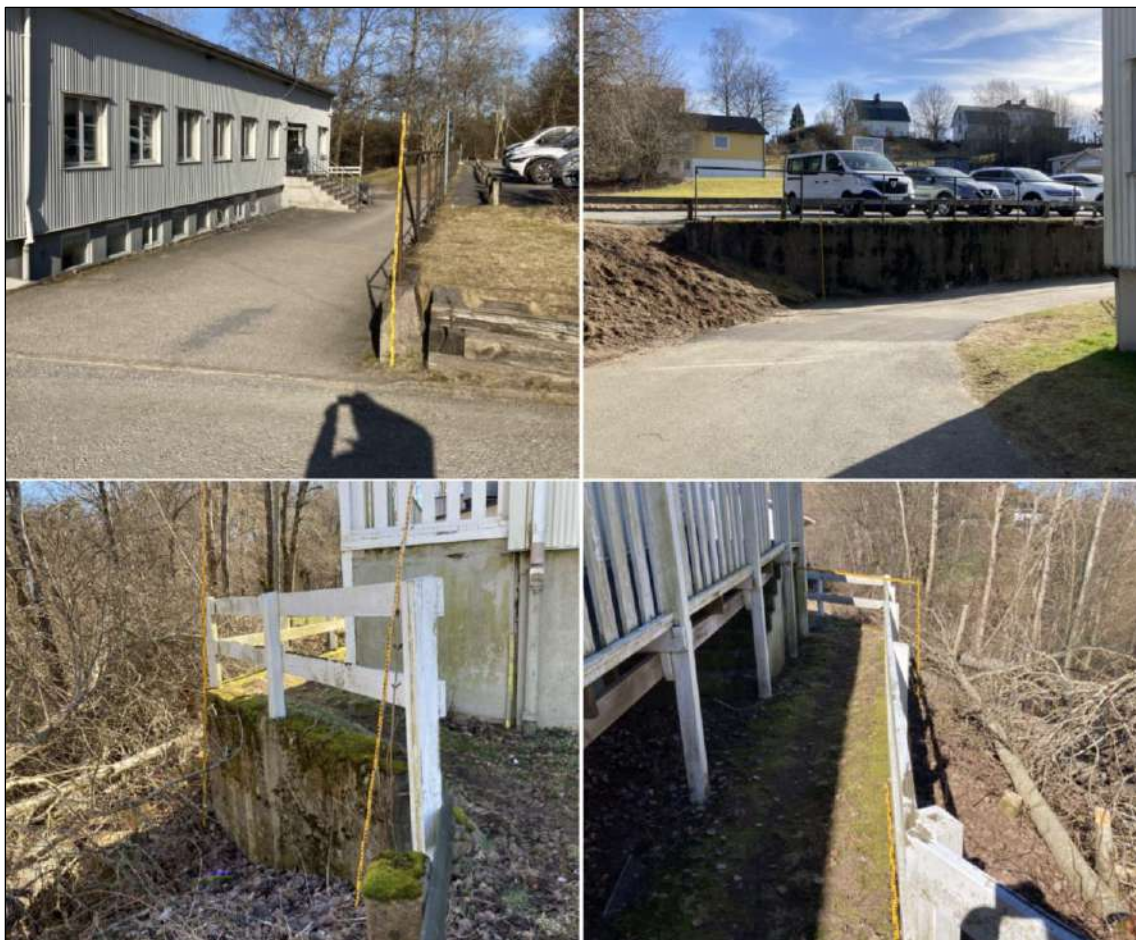
Figur 2: De övre fotografierna visar befintlig stödmur mellan parkeringsplats samt södra kortsidan av Kinnahallen. De nedre fotografierna visar befintlig stödmur mellan östra sidan av Kinnahallen och Viskan.
