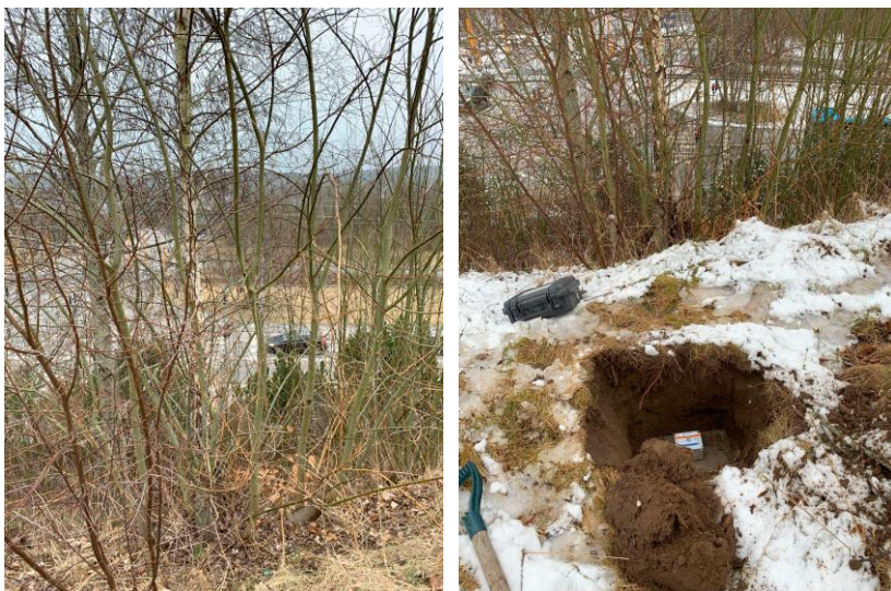
Figur 3 Montering av Triaxiell givare AT inom planområdet närmast korsningen på Nya Kinnavägen. Foto till höger visar givaren monterad på trädgårdsplatta.
