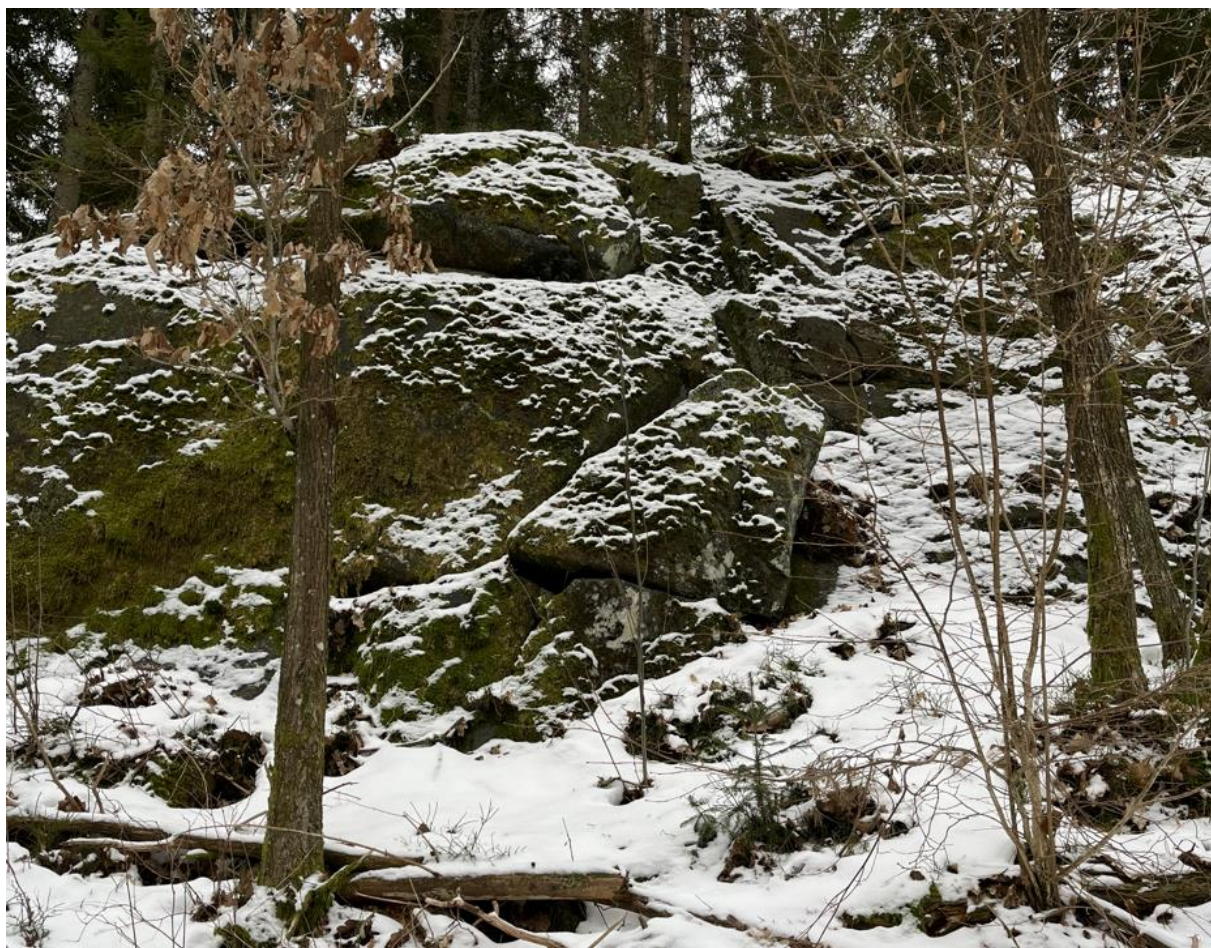
Figur 5.4. Block som trycks ut från bergslänt markerat med rött, foto taget söderifrån.
